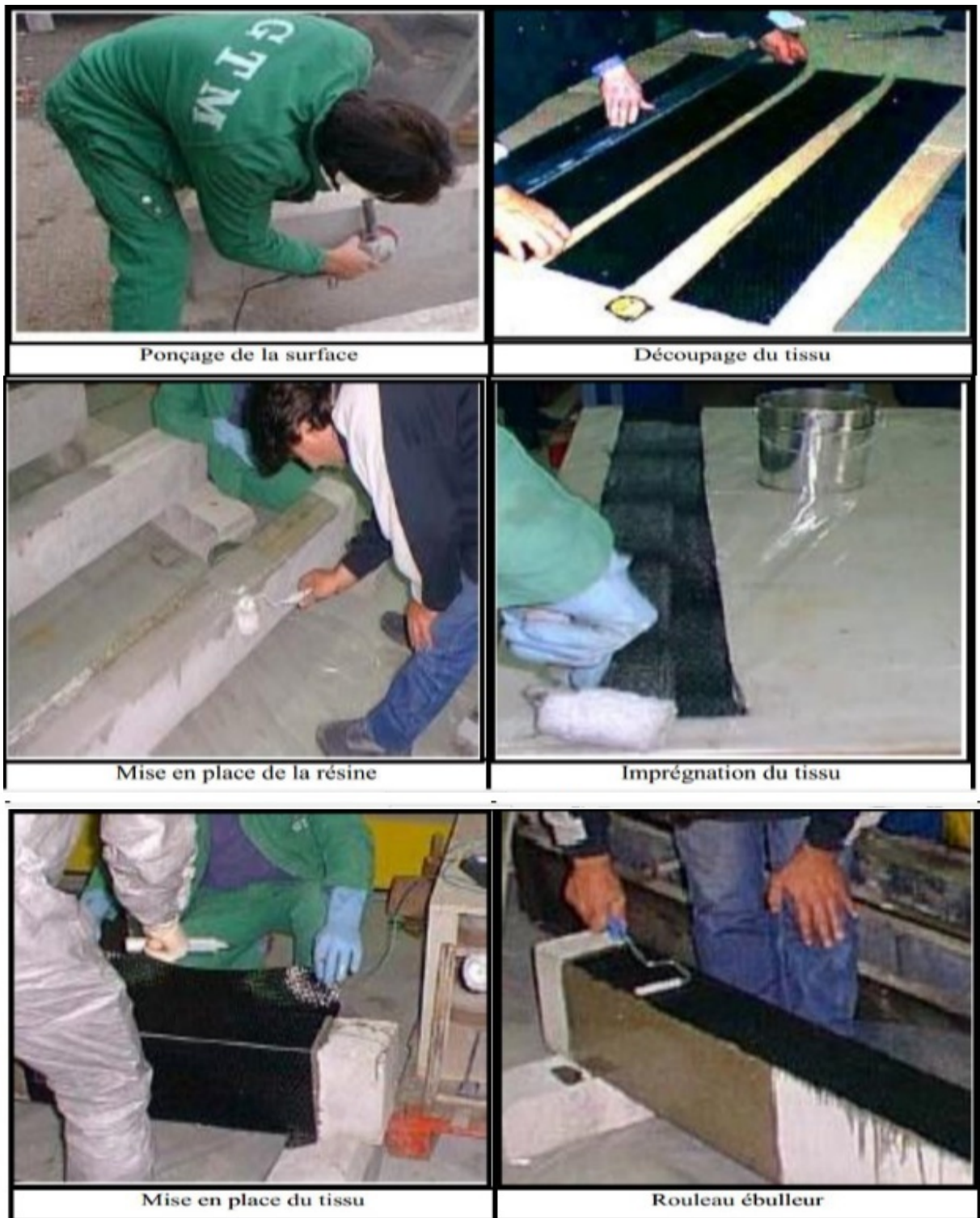
Figure I.10 : Mise en œuvre d'une réparation par stratification [Chedad 2016]
