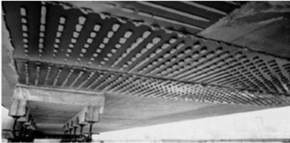
Figure I.9: Renforcement d'un viaduc par tôles collées. [Chedad 2016]
