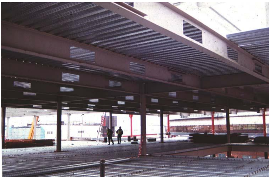
Figure I.1. Ouvertures rectangulaires isolées dans une poutre mixte [2]
