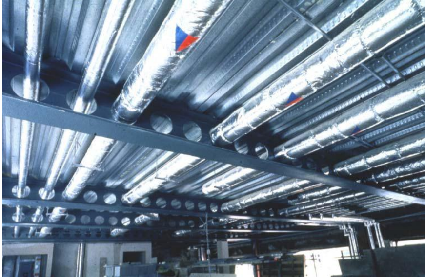
Figure I.2. Poutre cellulaire munie d'ouvertures circulaires régulières [2]
