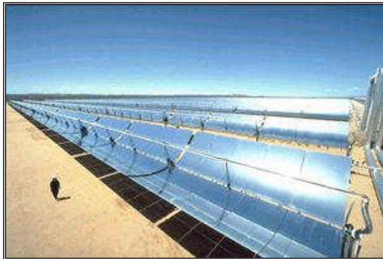
**FIGURE I.6 :** *Système à réflecteur cylindro-parabolique.* [17]
