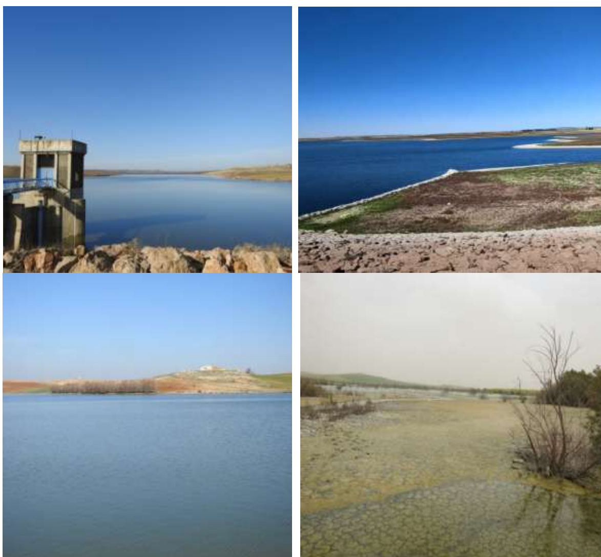
Figure n°15 : Différents points d'observation cas du Barrage Dahmouni (Latab, 2017)
