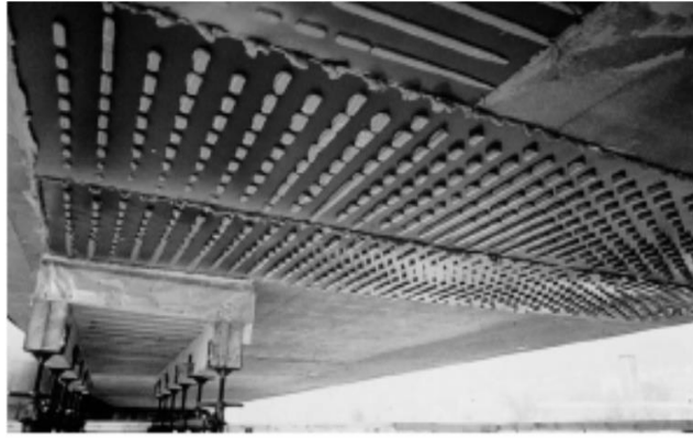
Figure II.8 : Renforcement d'un viaduc par tôles collées.
