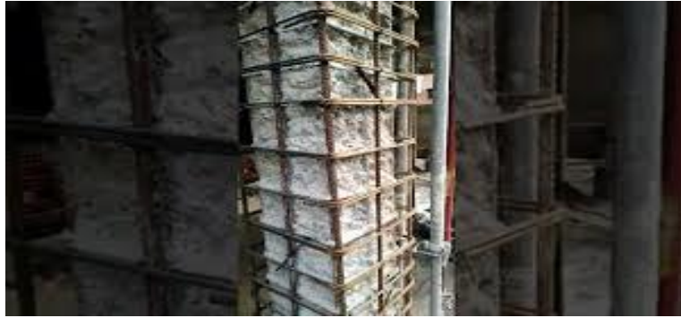
Figure II. 4: Chemisage en béton armé.
