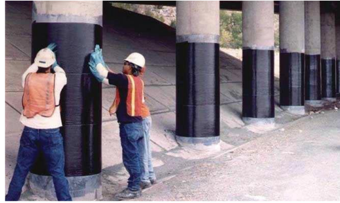
Figure III. 4 : Application d'un confinement CFRP sur des piles de ponts.
