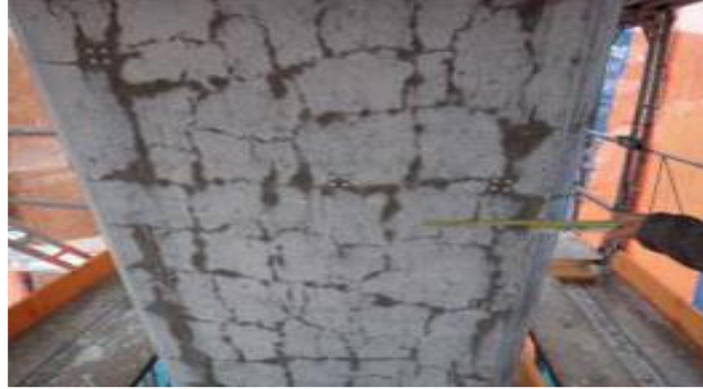
Figure I.1 : Phénomène d'alcali-réaction.
