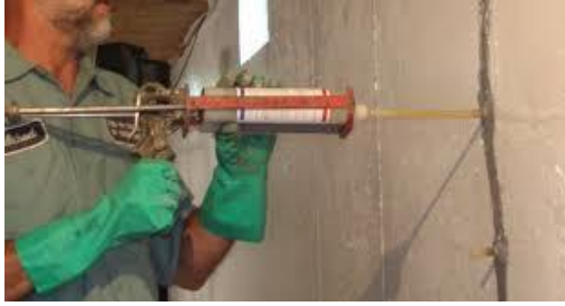
Figure II. 5: Traitement des fissures techniques d'injection
