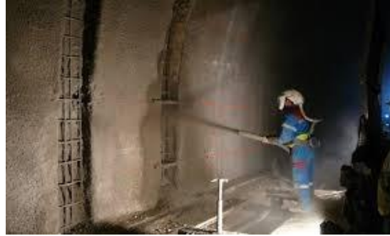
Figure II. 2: Réparation en béton projeté.
