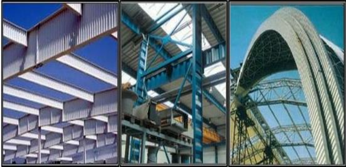
Figure II.4 : Poutre ondulée dans les bâtiments industriels
