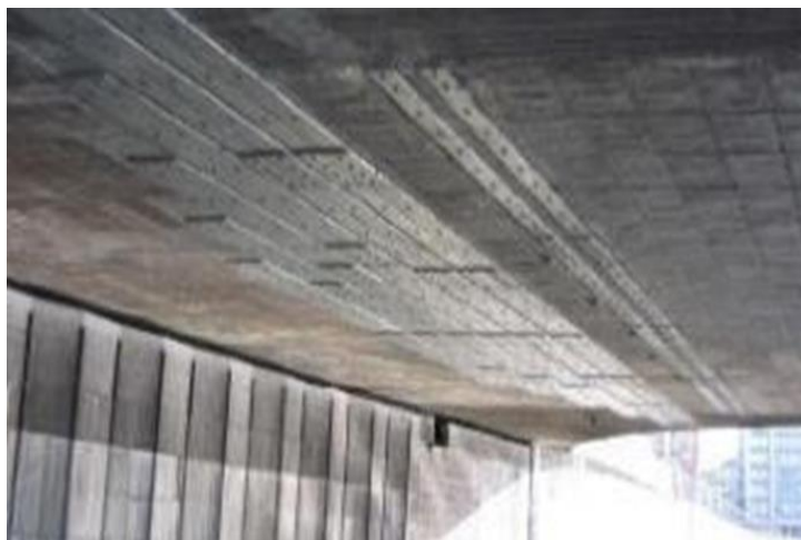
Figure I.10: Renforcement par plats métalliques. (Bouabdellah, 2023).
