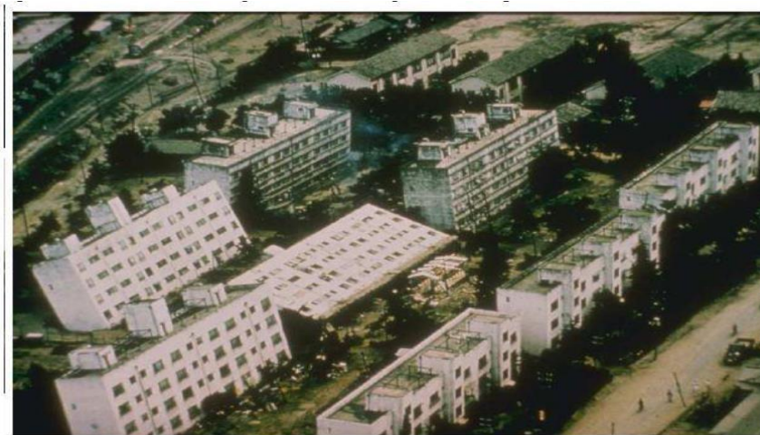
Figure I.6 : Séisme de Niigata 1964 Quartier Kawagishi-Cho (BOUACHRIA and KARI, 2021).
