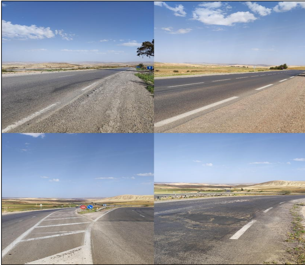
Figure I.3 : Photos du tracé de notre projet routier sur la RN23.
