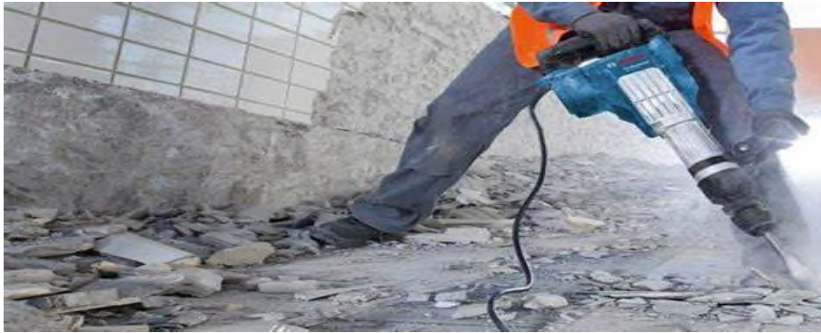
Figure .I.3. Démolition avec Outils portés [11].
