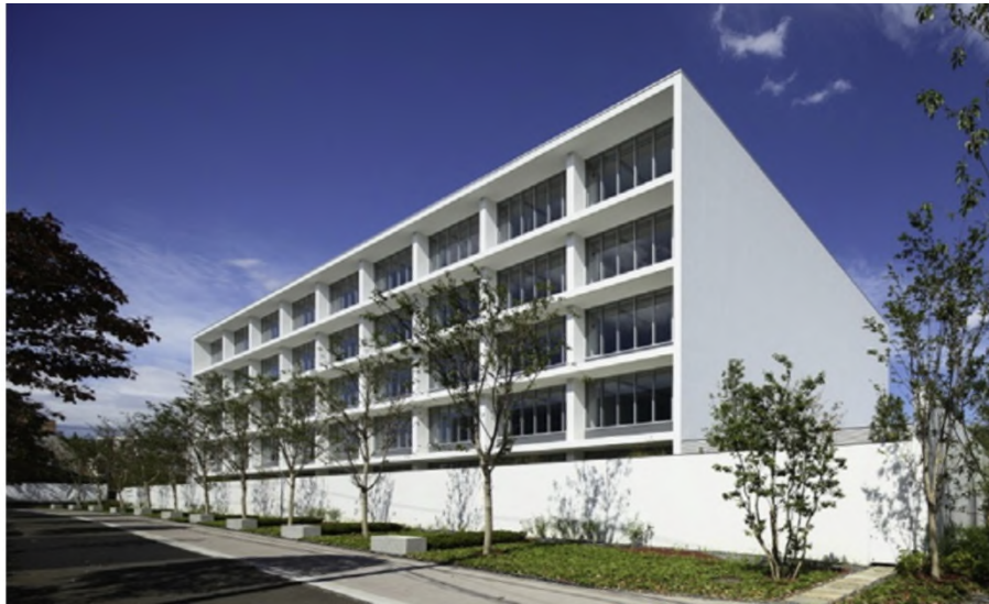
Figure .III.13. Construction d'un bâtiment avec granulats recyclés [74].
