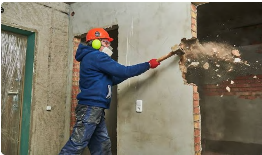
Figure .I.4. déconstruction manuel [11].
