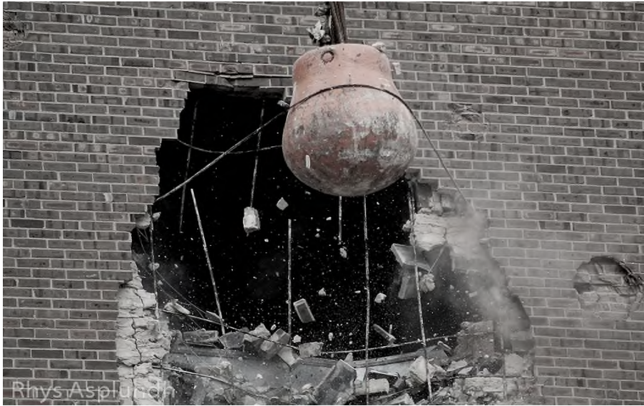
Figure I.2. boulets de démolition [8].
