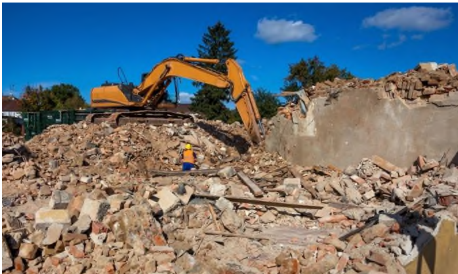
Figure .I.6. de déchets de construction [14].
