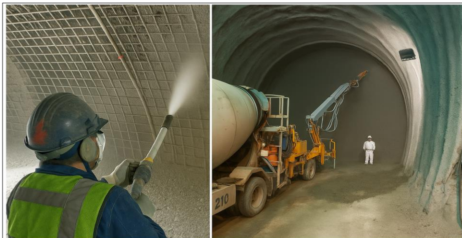
Figure II.17: L'application du béton projeté (KAHOUL, 2021).
