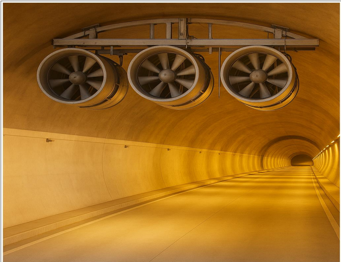
Figure I.22: Ventilation d'un tunnel voûté (CETU, 2003).
