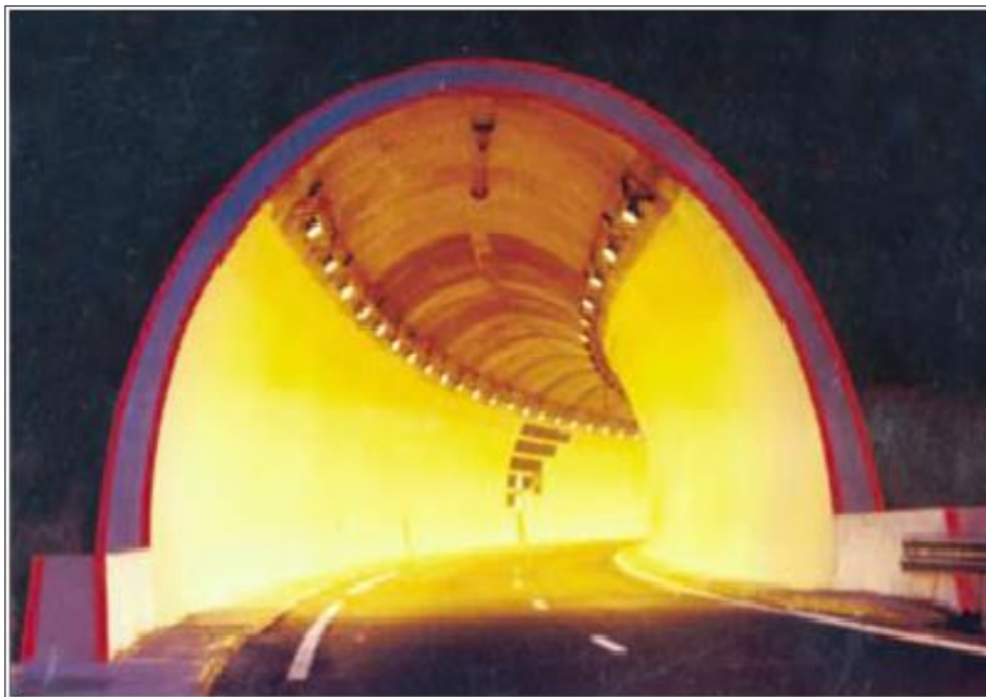
Figure I.21: Tunnel de la Grand-Mare à Rouen (France) (CETU, 2000).
