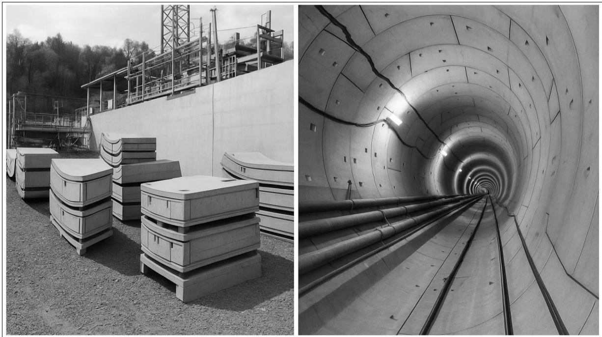
Figure II.20: Voussoirs en béton préfabriqués (CETU4, 1998).
