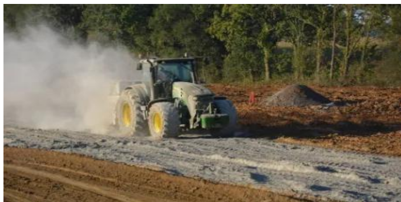
Figure II.17 : Chantier de traitement au ciment du sol (Boutira, 2021)
