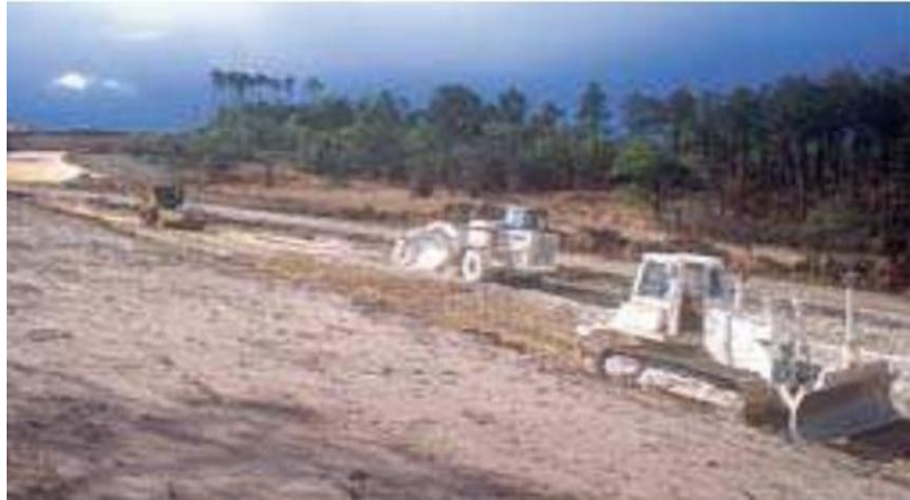
Figure II.16 : Chantier d'un traitement à la chaux du sol (Rouabhia, 2017)
