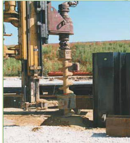
Figure1.27: Perforage avant fonçage
