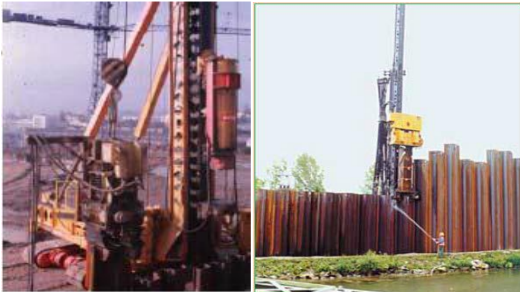
Figure1.23: Chantier de battage
