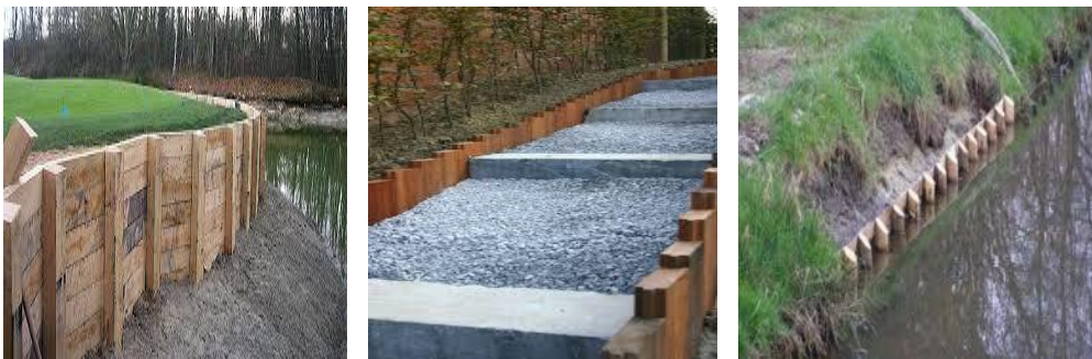
Figure1.4: Exemples de l'utilisation de palplanches es bois
