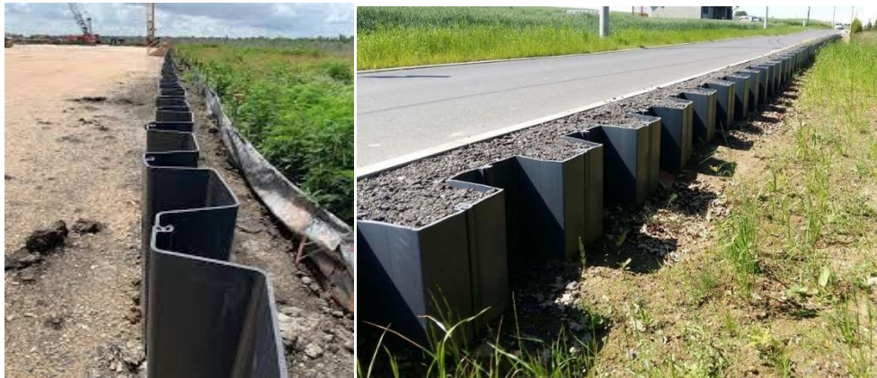
Figure 1. 7: Exemples de l'utilisation de palplanches en PVC
