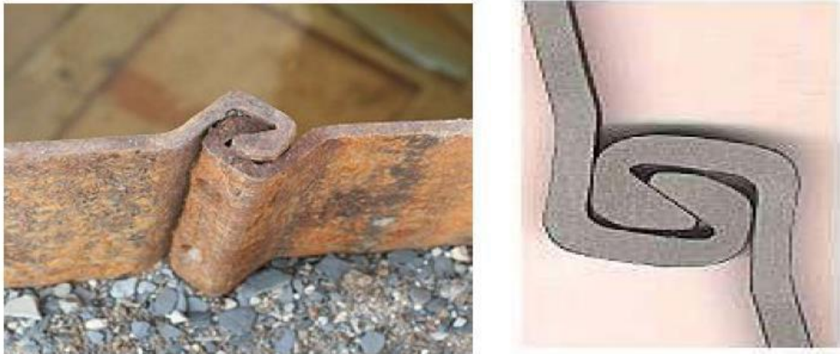
Figure1.17: Serrure à la jonction de deux palplanches.
