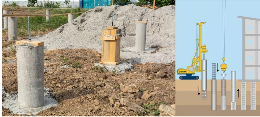
Figure 1.4 : exemple de fondations sur pieux
