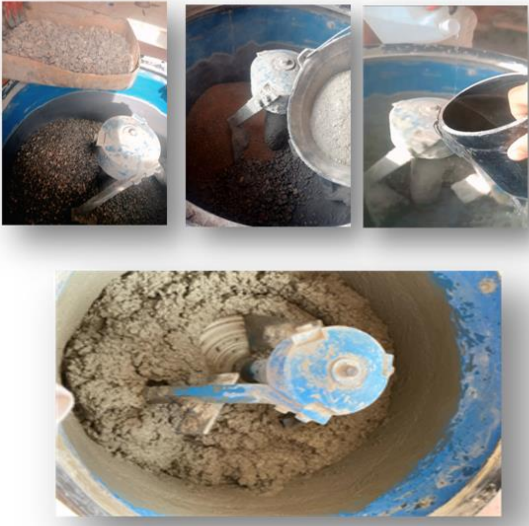
Figure 3.15 : Malaxage de béton.
