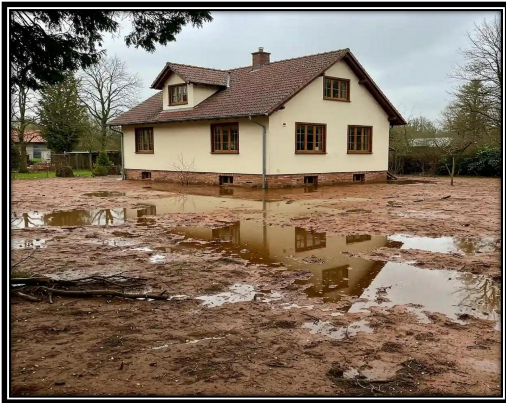
Figure II.1 :Maison sur sol argileux.
