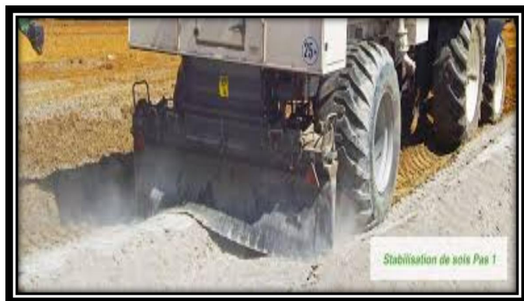
FigureI.3: exemple de stabilisation de sol
