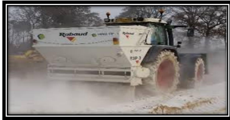
FigureI.2: Travaux de stabilisation des sols dans la région de Redon
