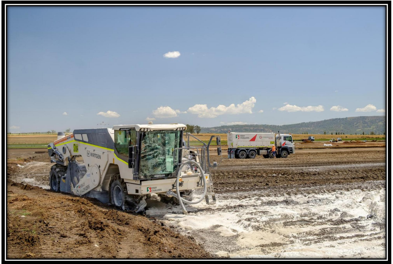
Figure I.4: La chaux dans la stabilisation des sols.
