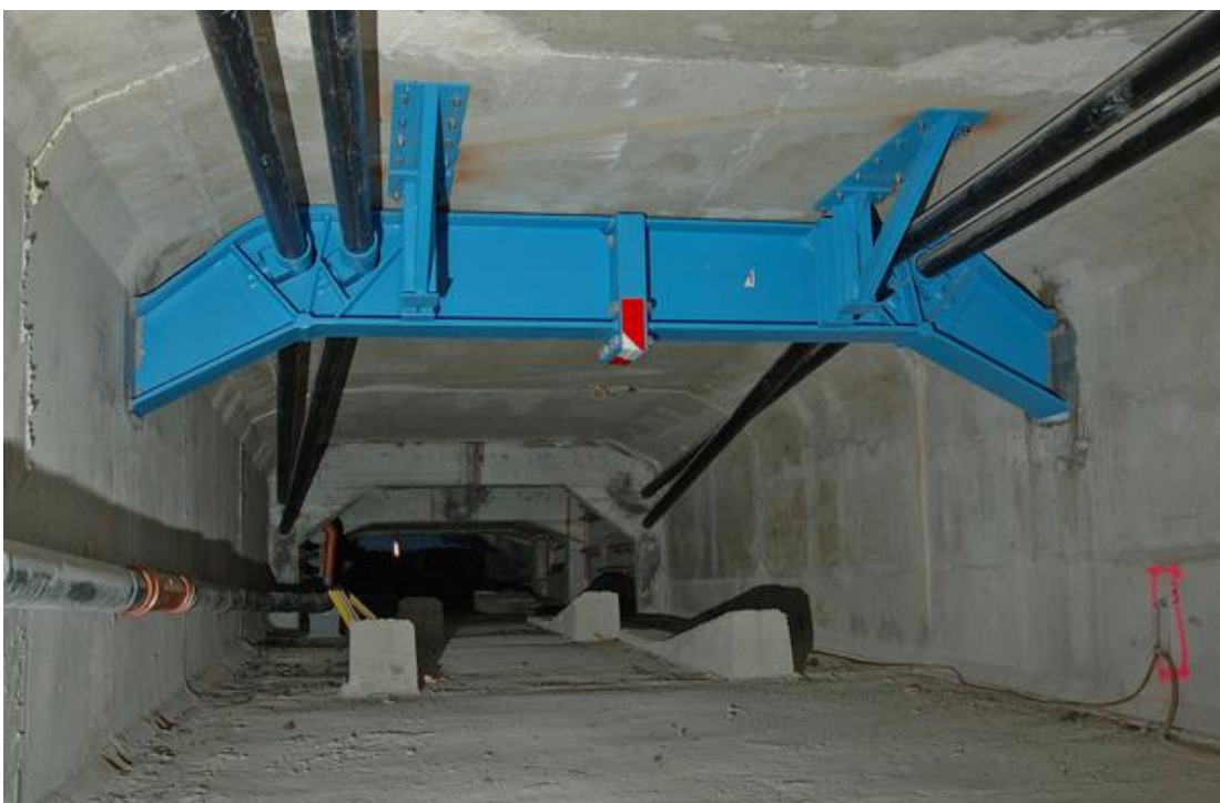
Figure I.13 : La technique de précontrainte additionnelle (BADOUR, 2018)
