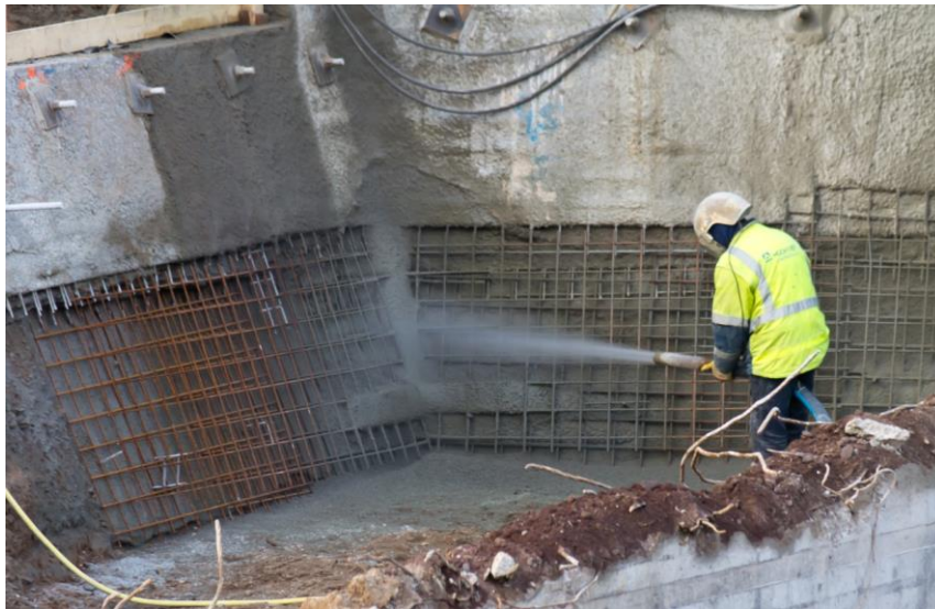
Figure I.11: Béton projeté par voie humide(BADOUR, 2018)
