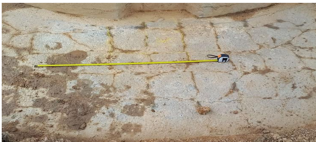
Figure.I.7 : Attaque sulfatique (BOUACHRIA and KARI, 2021)
