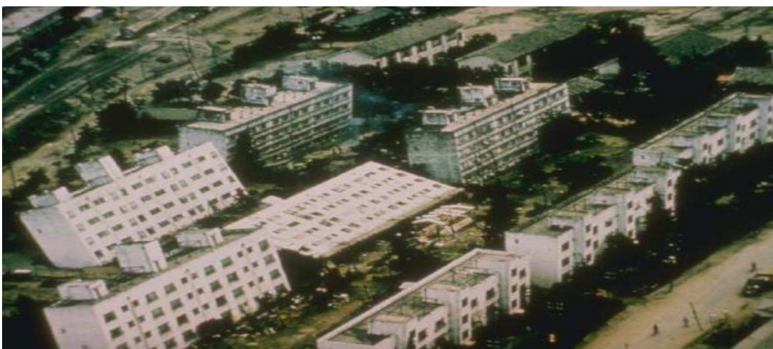
Figure.I.10: Séisme de Niigata 1964 Quartier Kawagishi-Cho(BOUACHRIA and KARI, 2021)
