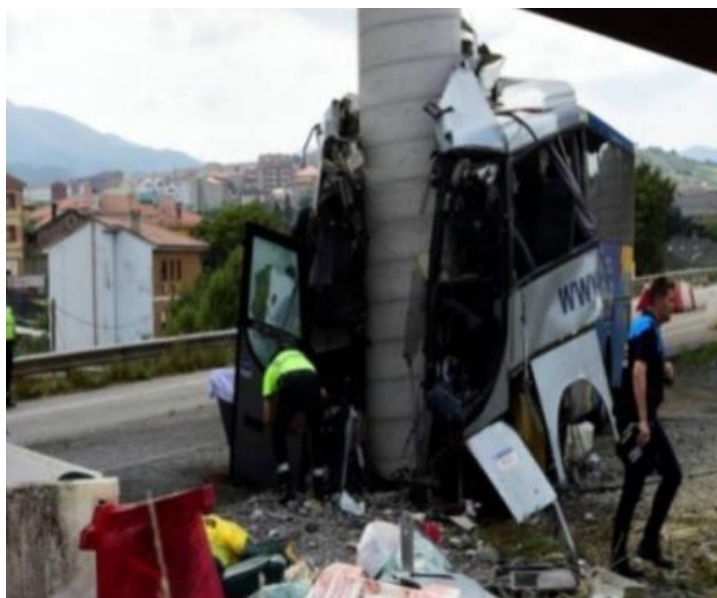
Figure.I.5: Grave conséquence de collision contre la pile d'un pont (d'un véhicule)(BOUACHRIA and KARI , 2021)
