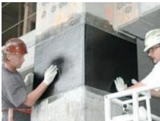
Figure I.15: renforcement en fibres de carbone( MAHOUZ and NOUARI, 2024)
