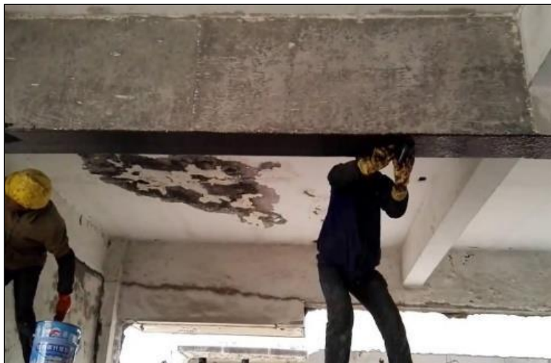
Figure II.7 : Applications des FRP en génie civil, a) Pont de l'Autoroute 55 Nord (Magog – 2002), b) Pont Wotton (Municipalité de Wotton – 2001), (c) le renforcement d'une poutre par lamelles en FRPC.
