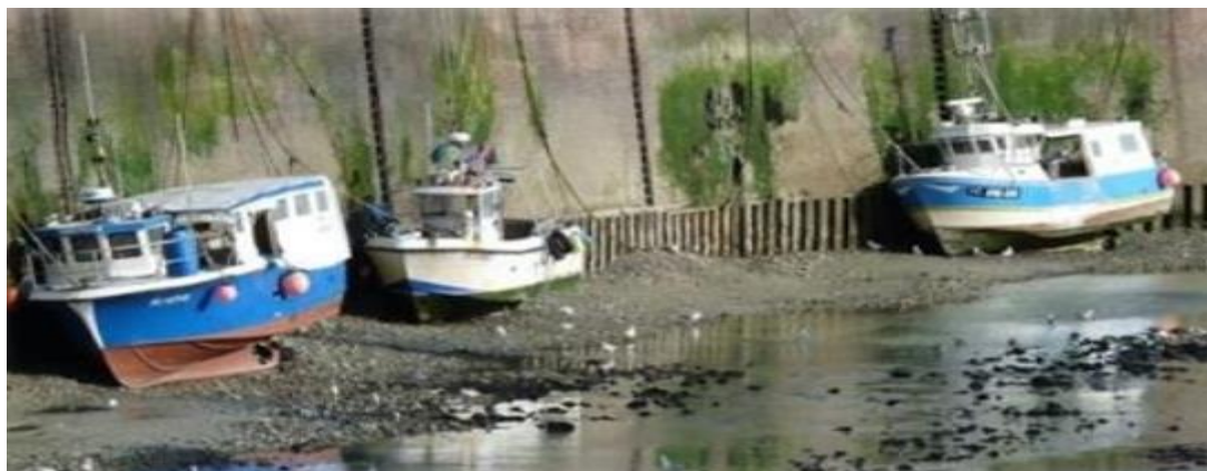
Figure.I.8: Altération d'un béton à la mer en zone de marnage(BOUACHRIA and KARI, 2021)
