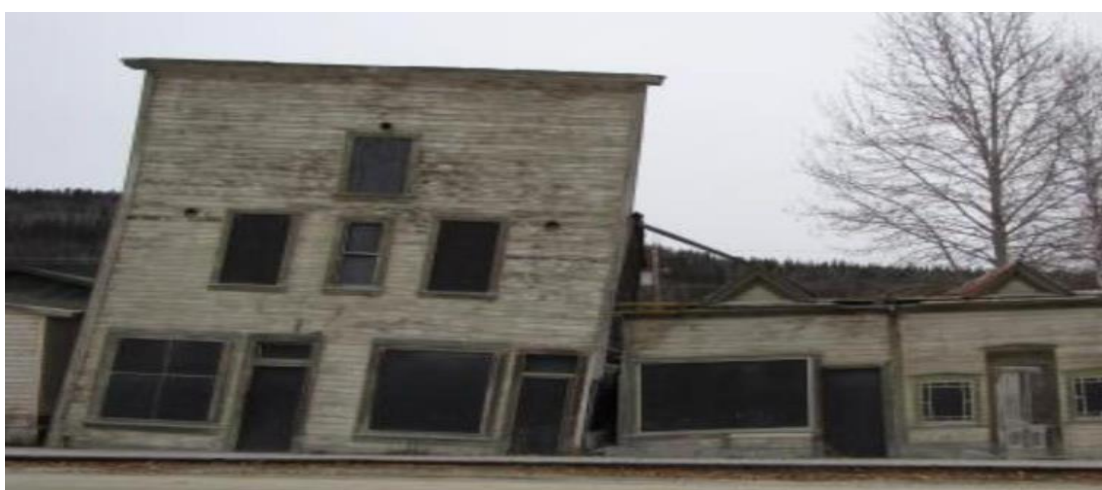
Figure.I.9: Tassement différentiel(BOUACHRIA and KARI, 2021)
