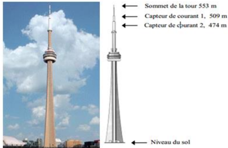
Figure I.12 : Mesure du courant de l'arc en retour à l'aide de la tour CN au Canada [19].2
