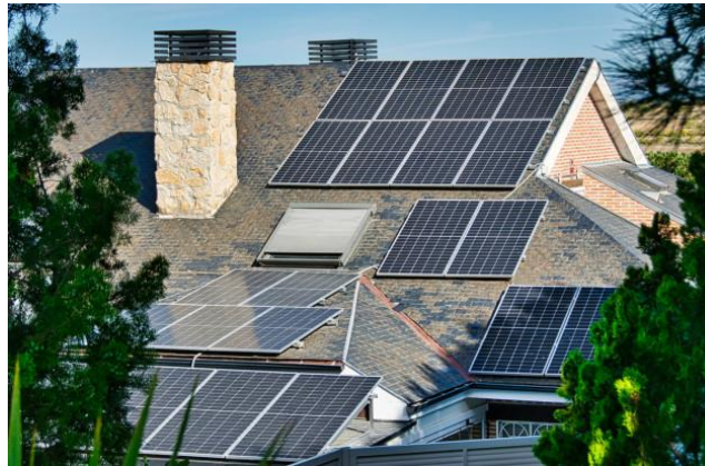
Figure I.6: Panneaux photovoltaïques pour un usage domestique.
