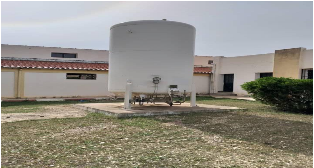
Figure 39 Réservoir d'azote liquide utilisé pour la conservation des semences dans un centre d'insémination artificielle.
