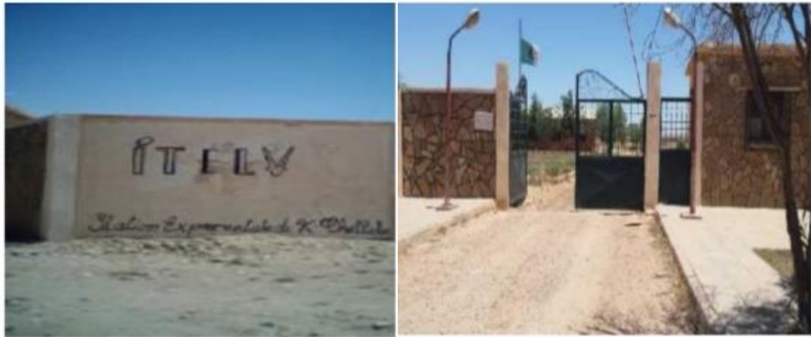
Figure N° 22 : Entrée de l'ITELV de Ksar Chellala (Photo personnelle, 2025)
