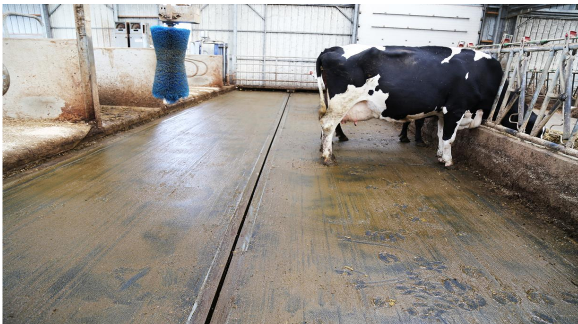
Figure N °-4 : Des tapis en caoutchouc, installés dans le couloir d'alimentation https://www.eleveur-laitier.fr
