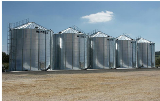
Stockage en Silos en métal
