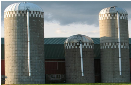
Stockage en Silos en Béton
