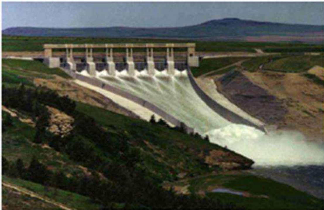
Figure III. 12. Évacuateur de crues de surface
