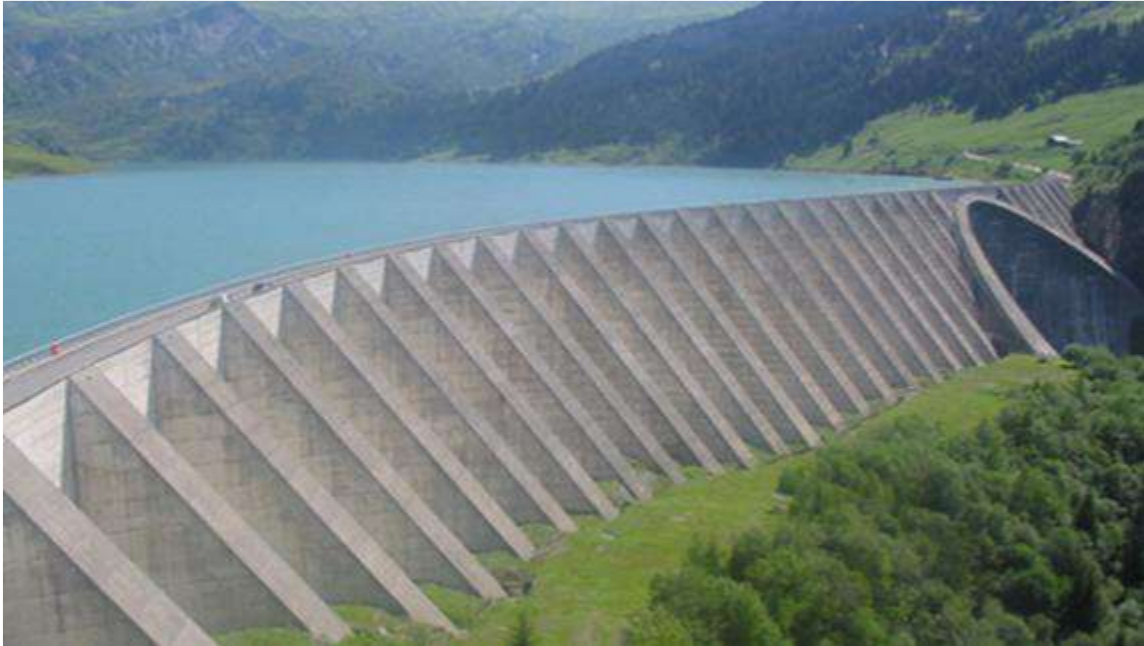
Figure III. 6. Barrage à contreforts d'Albert ville, Rhone-Alpes, France
