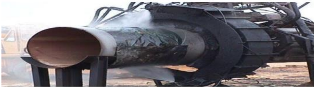
Figure I-13 Revêtement d'un tube. [29]
