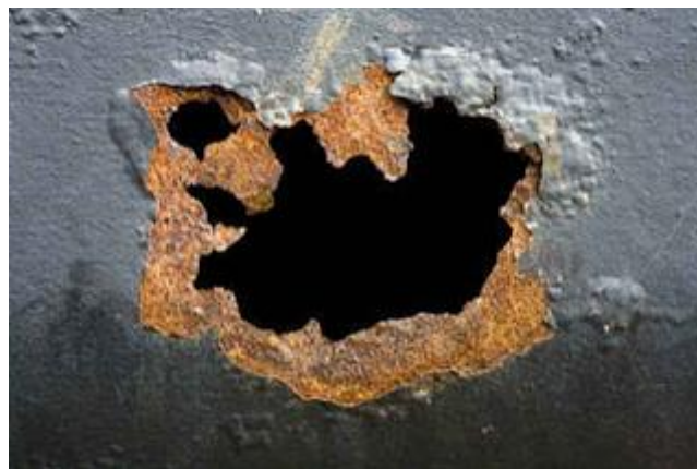
Figure I-6 Corrosion par piqûre. [12]
