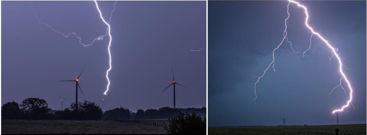
Figure I.12 : Impact de foudre sur les éoliennes [21], et le réseau électrique [22].
