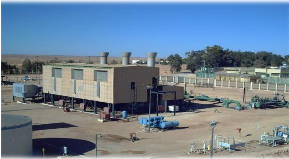
Figure 2.4 Station OZ1 '28' premier ouvrage réalisé par SONATRACH mise en service en 1966 capacité de transport 21MTA de pétrole [10].
