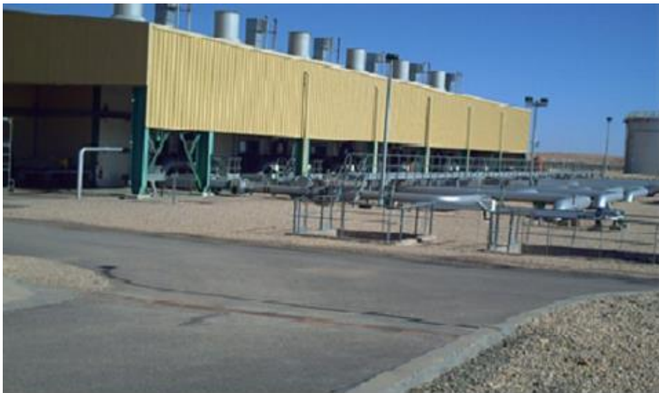
Figure 2.5 Station OZ2 '34' réalisé en parallèle de OZ1 afin d'augmenter la capacité de transport du pétrole mise en service en 2003 capacité de transport 34MTA [10].
