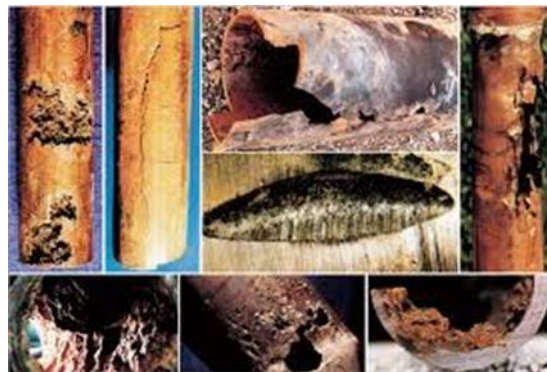
Figure II. 7 : Corrosion de matériaux métallique de traitement d'eau [64]
