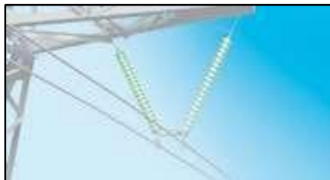
Figure I.22: Chaîne en V
