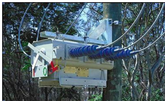
Figure I.33 : Interrupteur aérien télécommandé à distance [11]
