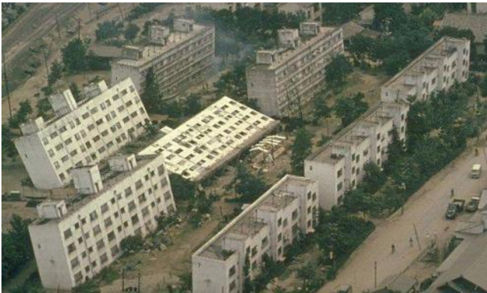
Figure I.8 : Le sol liquéfié entraîne l'inclinaison, voire le renversement, des bâtiments.
