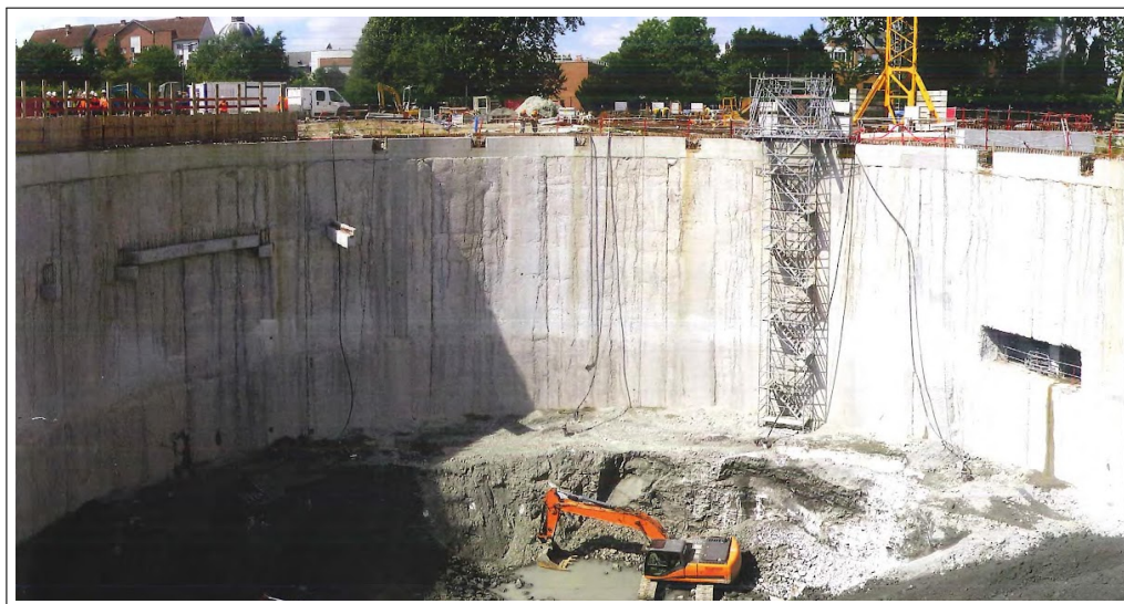
FIGURE 1.6 Application aux écrans de soutènement.
