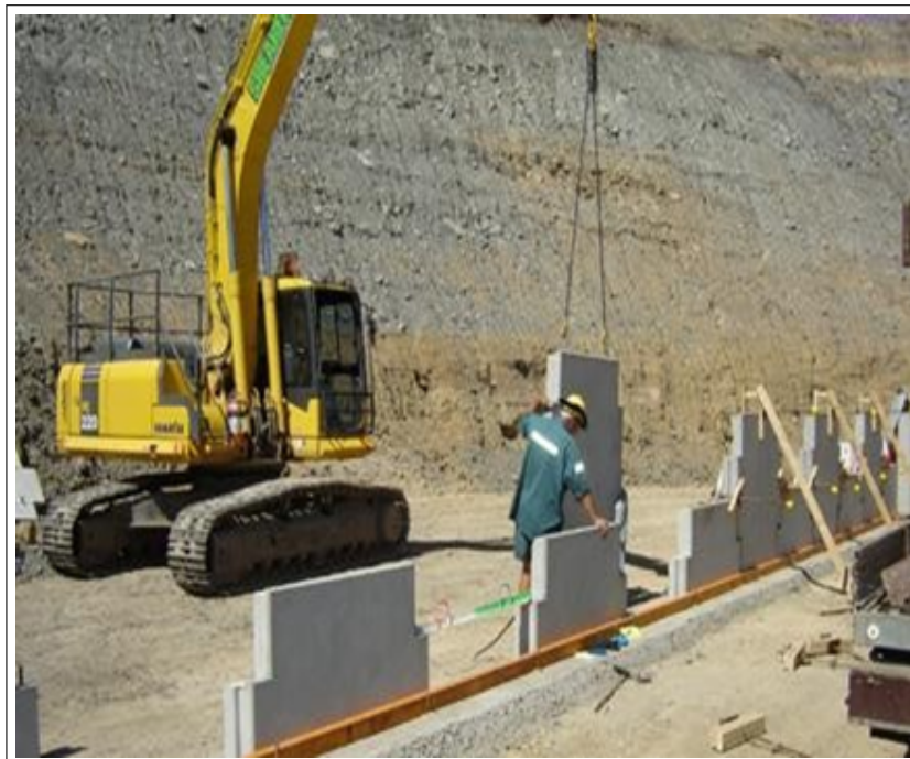
FIGURE 2.20 Installation et Stabilisation de la Première Rangée d'Écailles .
