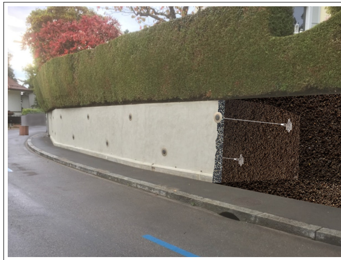
FIGURE 1.15 Ancrage, stabilisation et drainage de mur de soutènement et de toute sorte.
