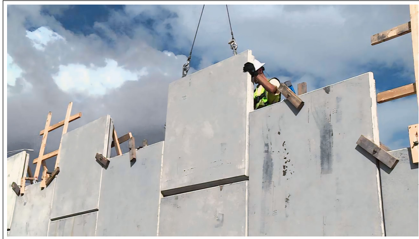
FIGURE 2.21 Procédure d'Installation et de Stabilisation des Rangées Supérieures d'Écailles .
