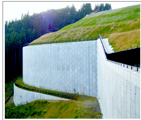
FIGURE 2.27 L'aspect final réalisation des travaux et modifications.
