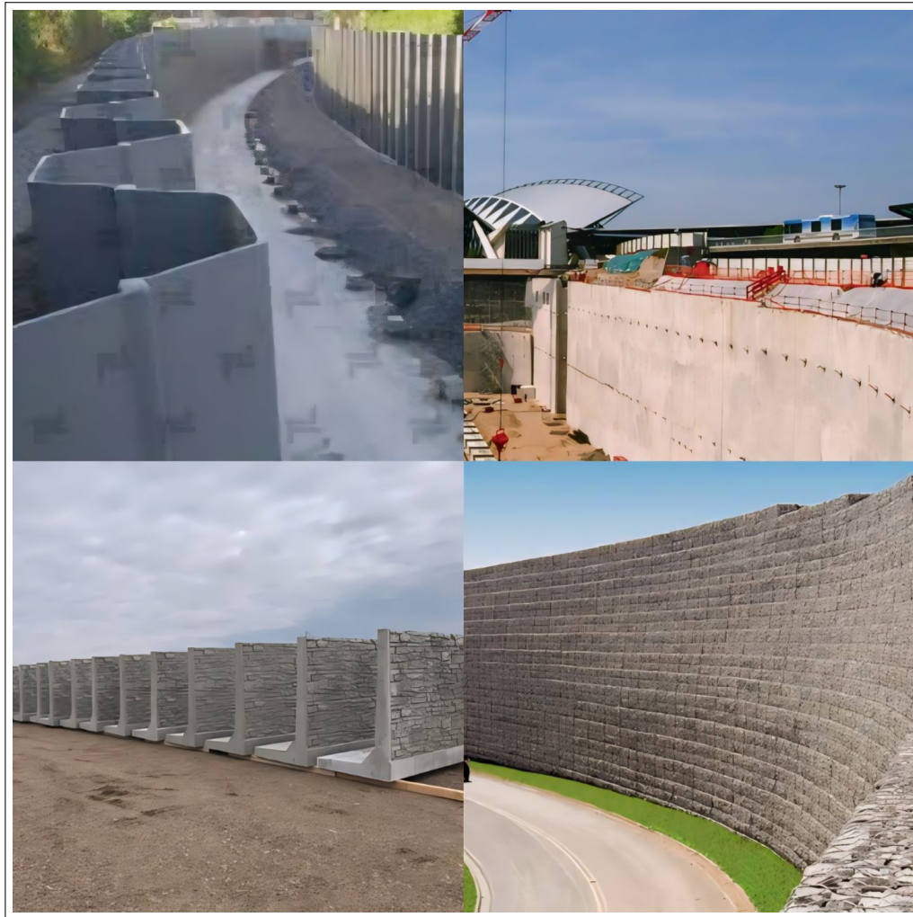
FIGURE 1.1 Les ouvrages de soutènement .
