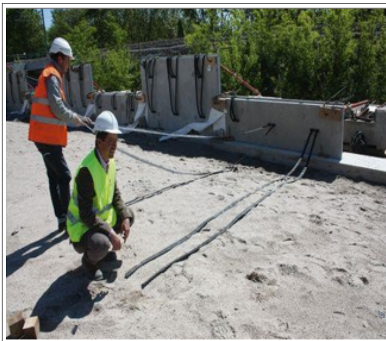
FIGURE 2.22 Photo de la pose d'un lit d'armature .
