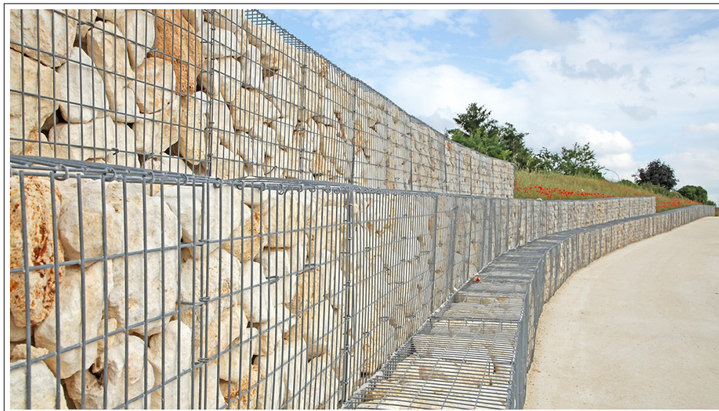
FIGURE 1.5 Ouvrage de soutènement en gabion.
