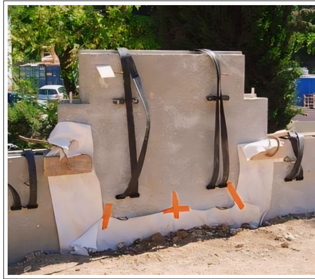
FIGURE 2.18 Systèmes de connexion GéoMega .
