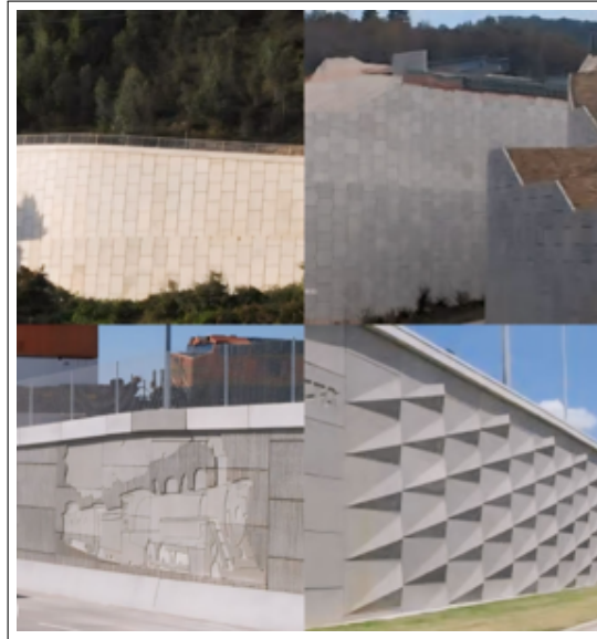
FIGURE 2.8 Différents types parement en écaillés de béton.
