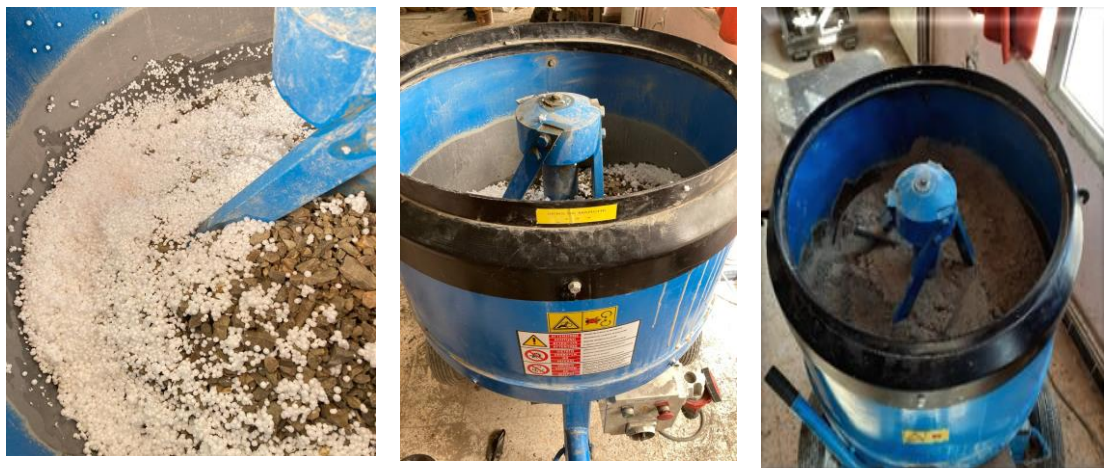
Figure III-15 - Préparation du béton : Mélangez le ciment, les granulats , polystyrène et
