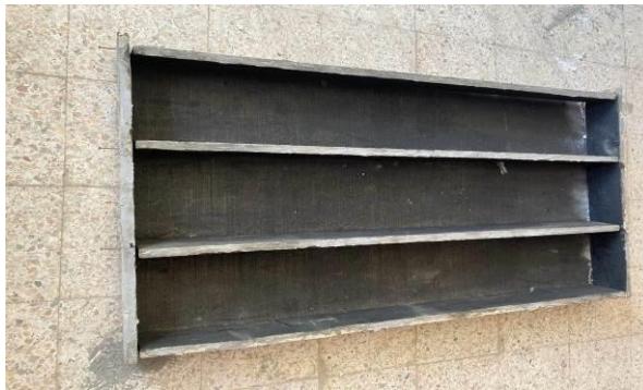
Figure III-16 – application des huiles sur les coffrages
