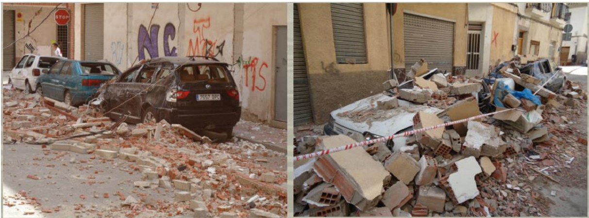
Figure V-3 - Chute d'éléments non structuraux : séisme de Lorca 2011
