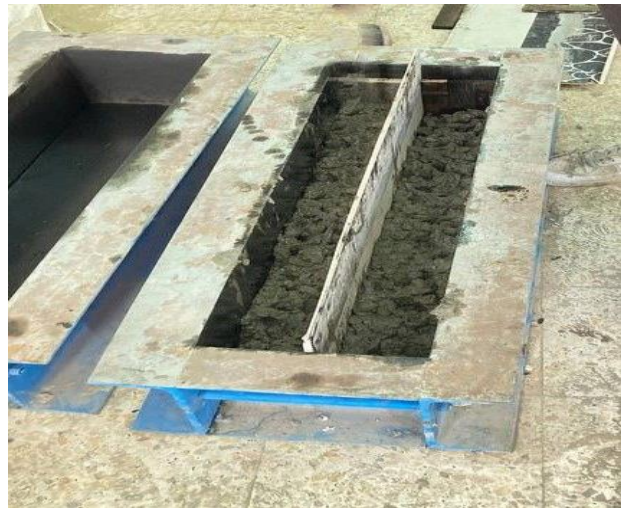
Remplissage poutres 10x15x80(b)
