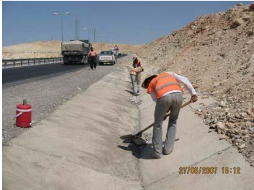
Figure IV.12 : Comment réaliser le nettoyage d'une tranchée ouverte
