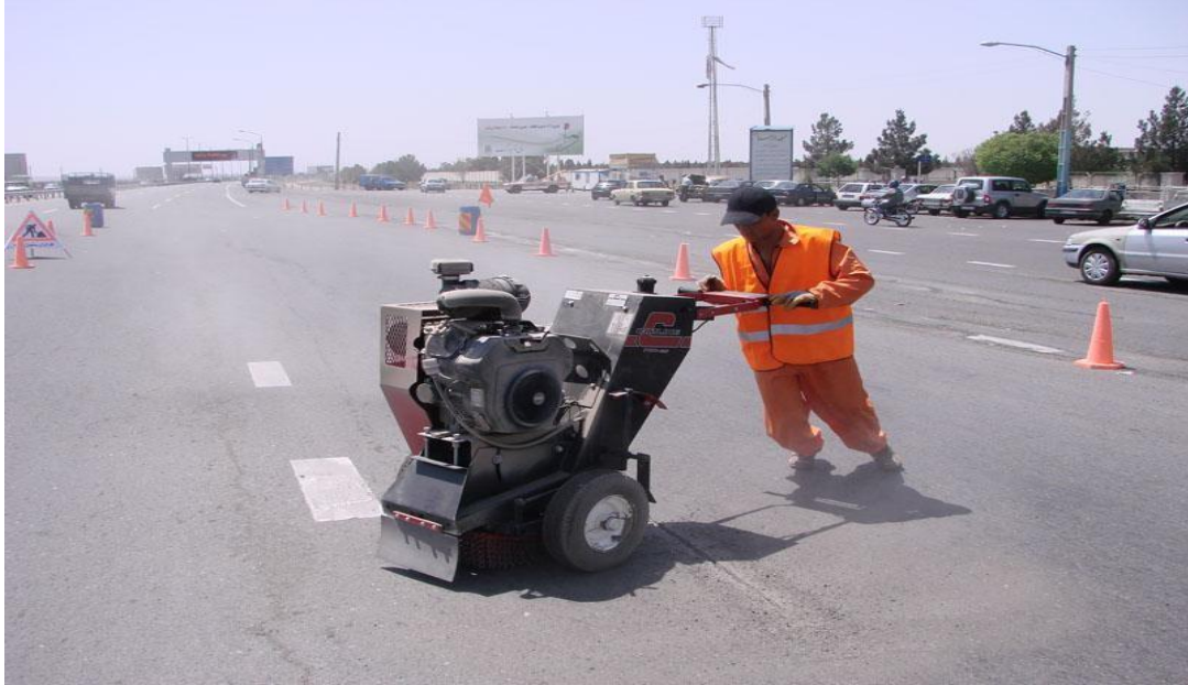
Figure IV.8 : Grattage des fissures à des longueurs et des largeurs appropriées
