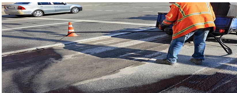
Figure IV.1: Réparations des dégradations
