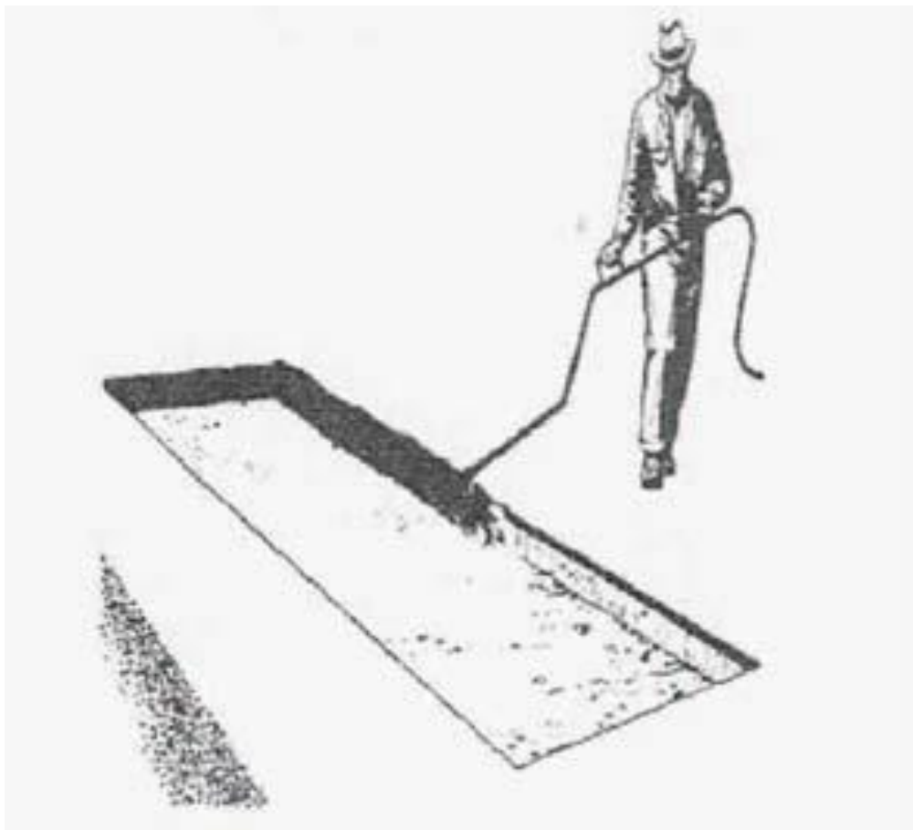
Figure IV.3 : Pulvérisation de bitume
