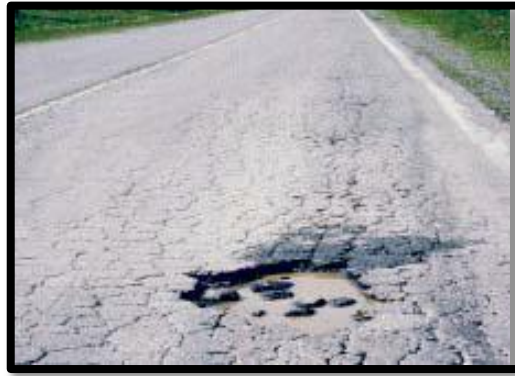
Figure II.10 : Les trois niveaux de sévérité pour le nid de poule
