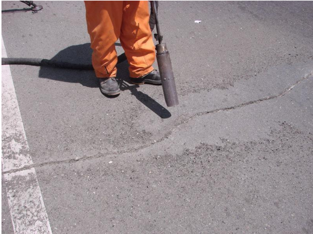
Figure IV.10 : Chauffage des murs de fissures
