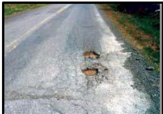
Moyen : diamètre 200 à 300mm
