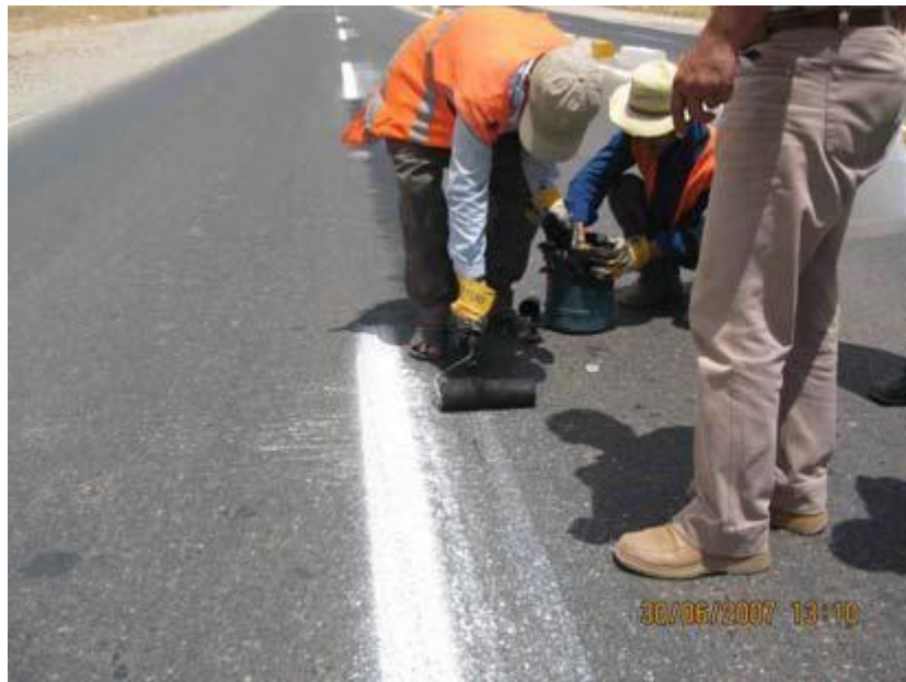
Figure IV.14 : Comment enlever et peindre les peintures endommagées
