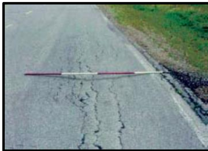
Figure II.6 : Les trois niveaux de sévérité pour l'affaissement.
