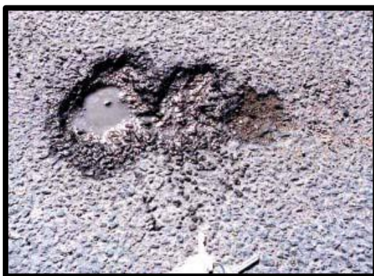
Faible : diamètre moins de 200mm
