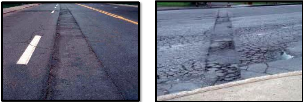
Figure II.14 : Coupe et tranchée.
