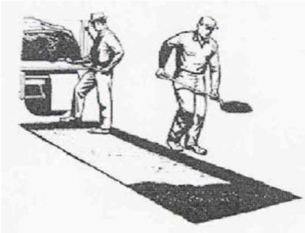
Figure IV.4 : Remplissage des nids-de-poule avec de l'enrobé bitumineux
