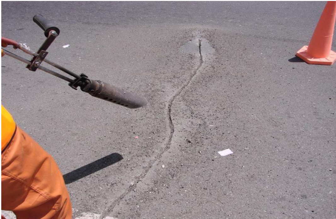
Figure IV.9 : Nettoyage des fissures
