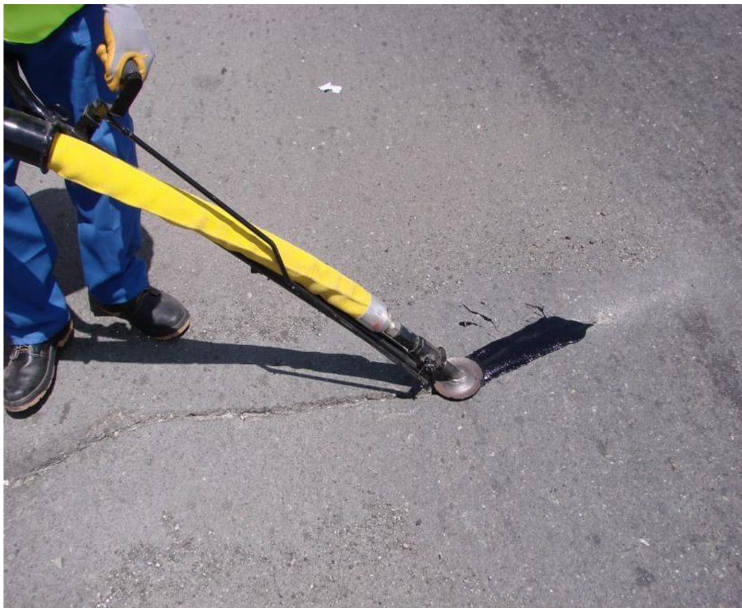
Figure IV.11 : Remplissage des fissures
