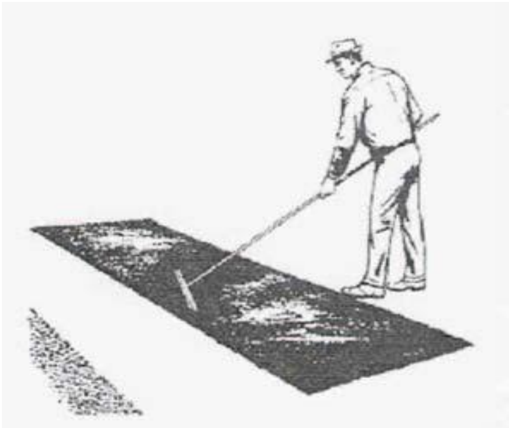
Figure IV.5 : Distribution d'enrobés bitumineux
