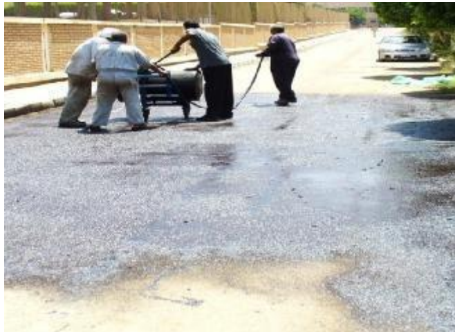
Figure IV.15 : Méthode de pulvérisation d'une émulsion d'asphalte sur la surface de la route.
