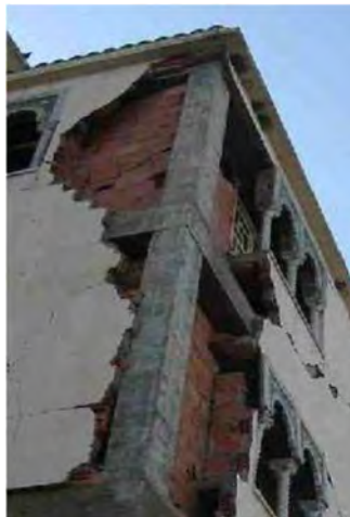
Figure I. 9 : Bâtiment en portiques et maçonnerie [2]
