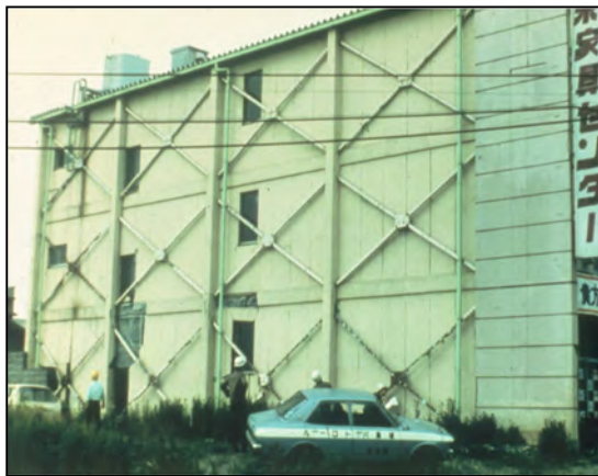
Figure I. 6: Contreventement par palée triangulée en X.
