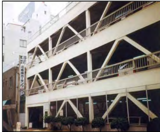
Figure I. 7 : Bâtiment avec palées triangulées en \Lambda .
