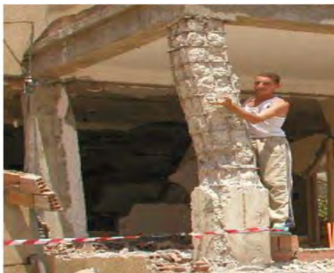
Figure I. 12 : Espacement constant entre cadres du poteau.
