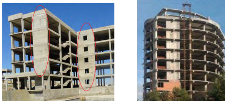
Figure I. 3 : Bâtiment à contreventement mixte (portiques/voiles).[1]
