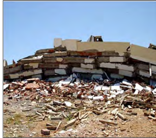
Figure I. 11 : Effondrement en mille-feuilles
