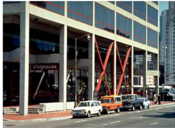
Figure I. 6: Contreventement par palée triangulée en X.
