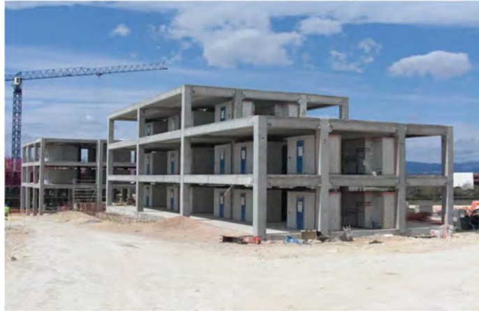
Figure I. 1 : Bâtiment en portiques en béton armé.
