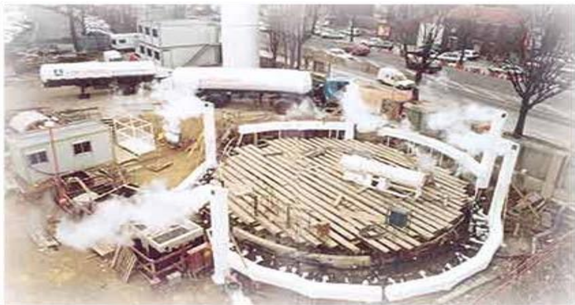
Figure. II.6 : Chantier utilisant la congélation du sol (Hamadouche, 2011).
