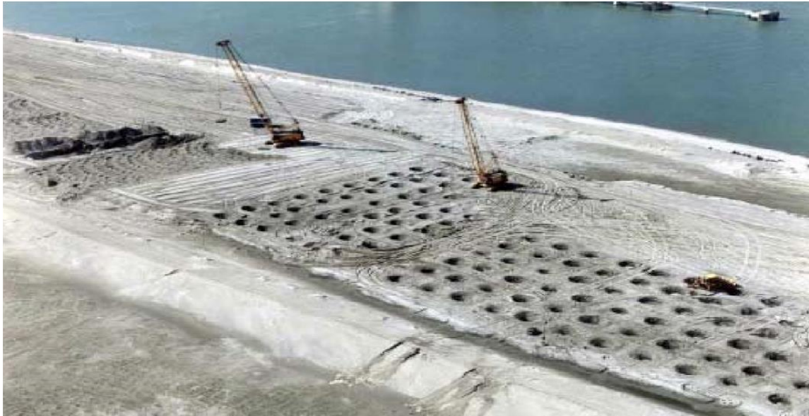
Figure. II.2 : Chantier d'un compactage dynamique profond (Lawton, 2004).
