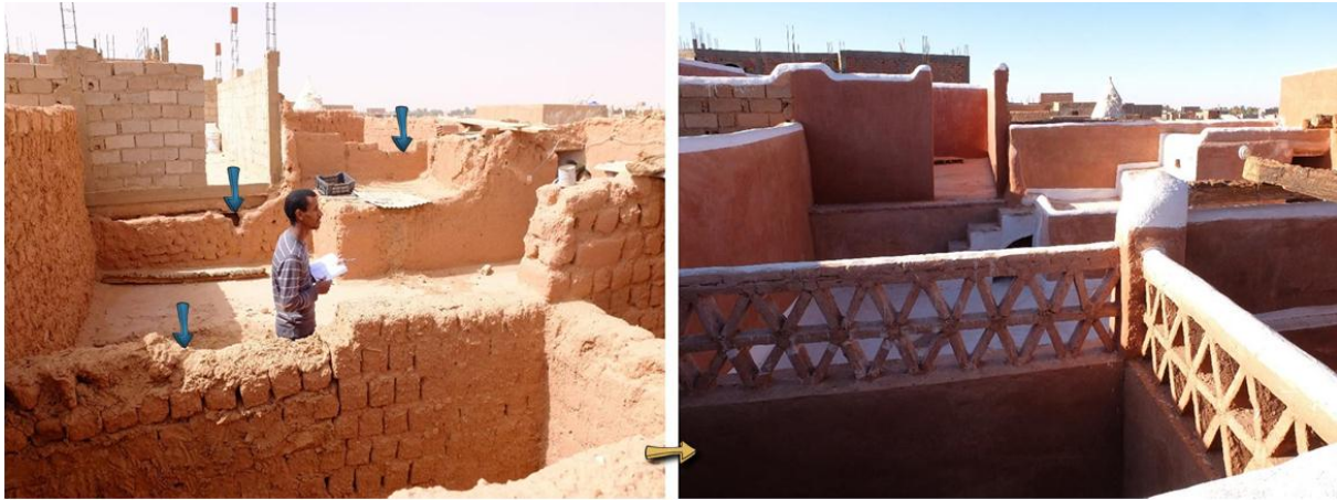
Figure 3.3. Préparation des mortiers et enduits.
