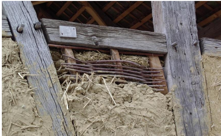
Figure1.2. technique de torchis.
