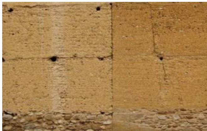
Figure 1.5. Technique de pisé.
