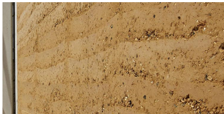
Figure1.4. technique de bauge.
