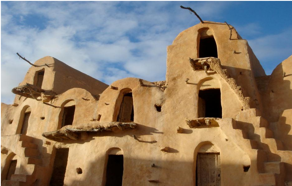
Figure 3.4. Enduit terre crue.
