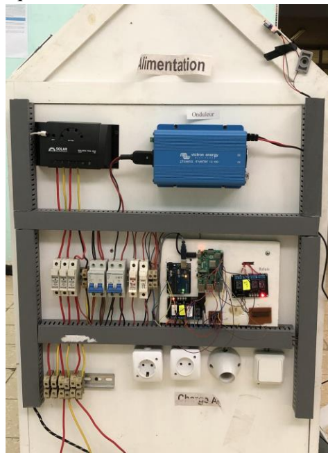
Figure III.15 : réalisation de l'alimentation.
