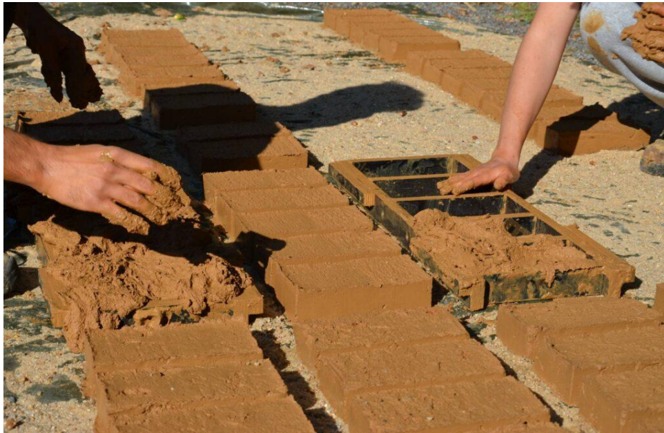
Figure1.3 : Fabrication brique de terre : adobe-terre crue
