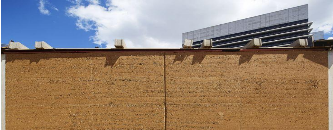
Figure 2.2 mur en terre crue
