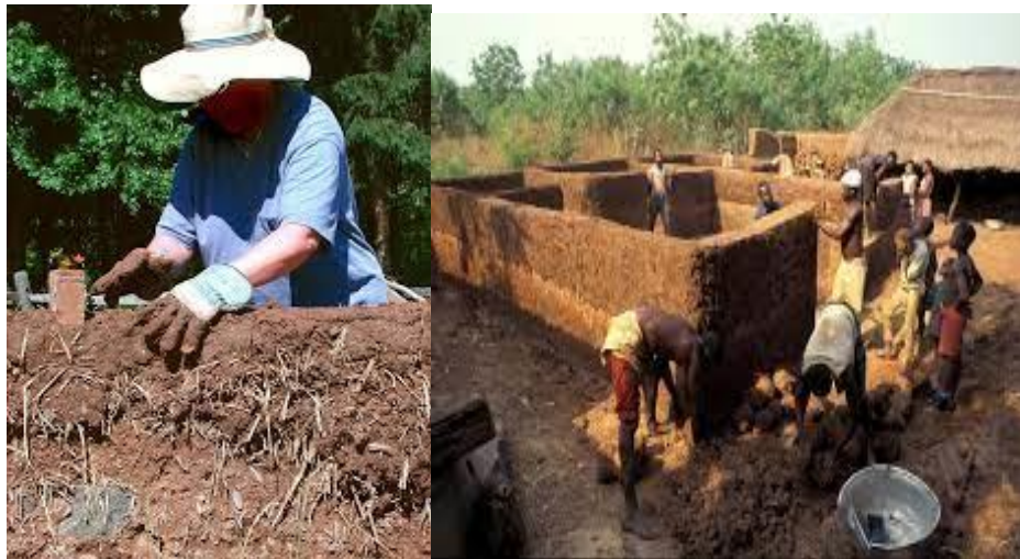
Figure 1.5 : Les techniques de la construction avec la bauge.
