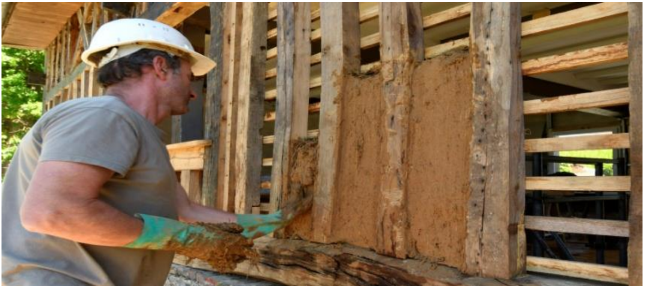
Figure 1.6 : Les techniques de la construction en torchis.
