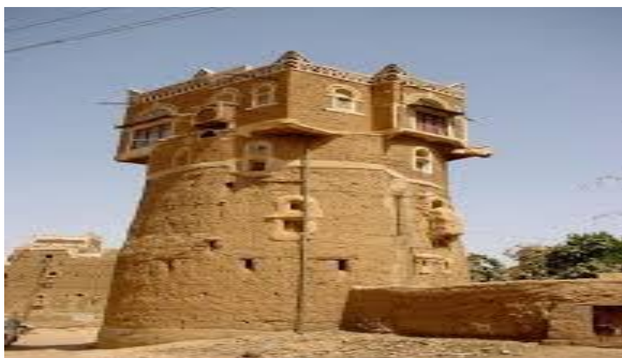
Figure 1-1 : bâtiment ancien en terre crue
