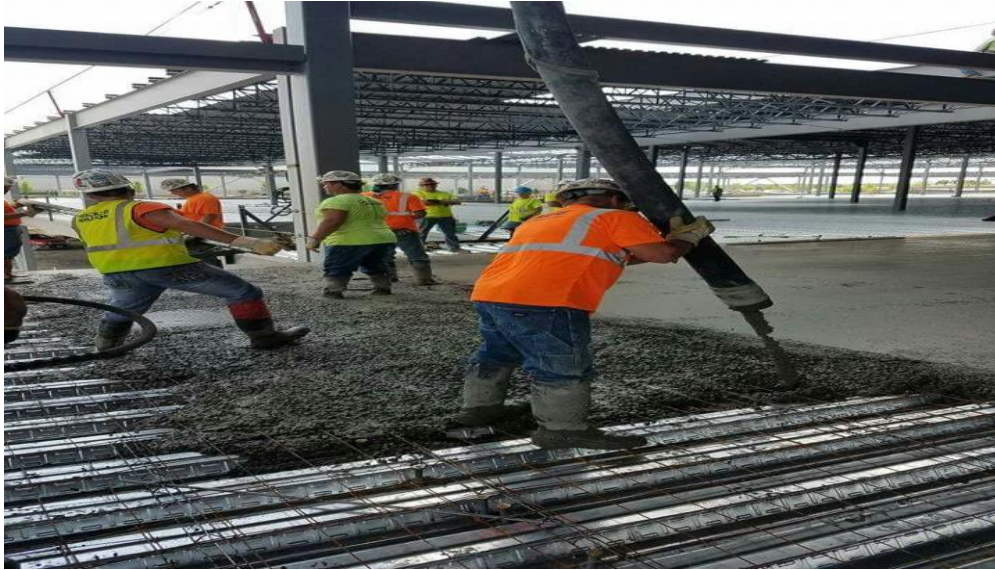
Figure I.8 : Réalisation de coulage d'une dalle mixte
