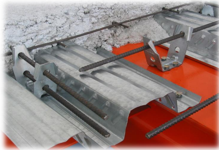
Figure I.5 : Dalle mixte acier-béton [3]
