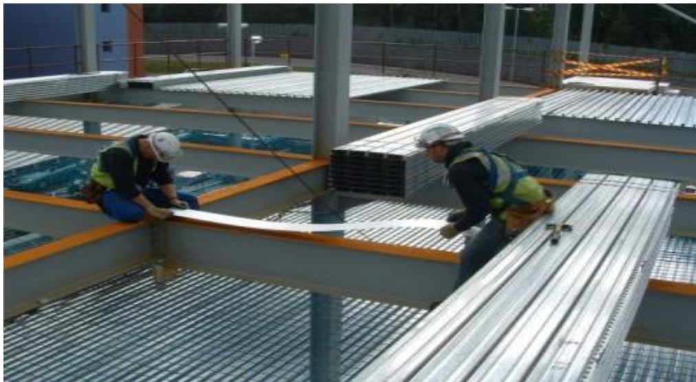
Figure I.10 : Réalisation des poutres mixtes ajourées
