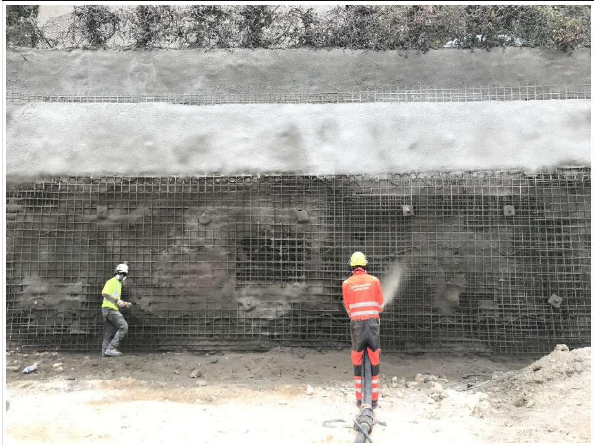
Figure 9.15. le béton projeté avec cloutage.
