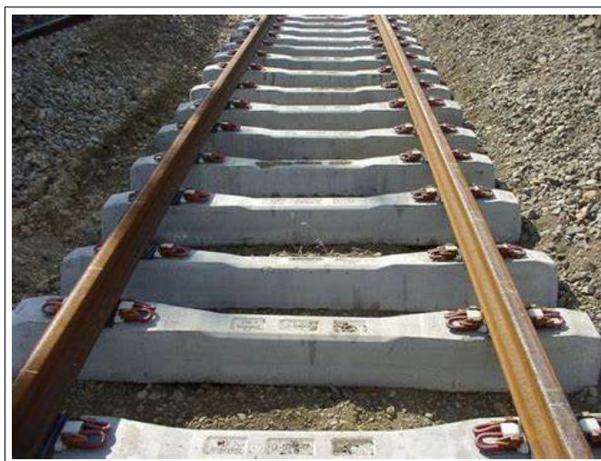
Figure 7.17. Traverses en béton.
