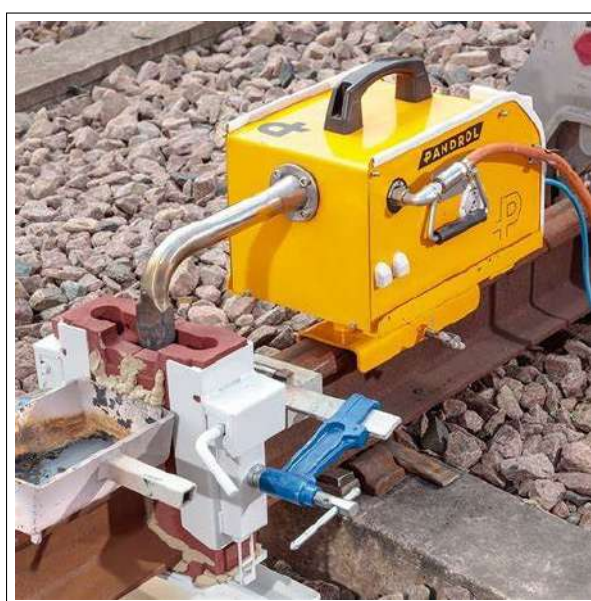
Figure 7.10. Préchauffeur HFP de rails à haut débit pour le soudage Alumino-thermique.
