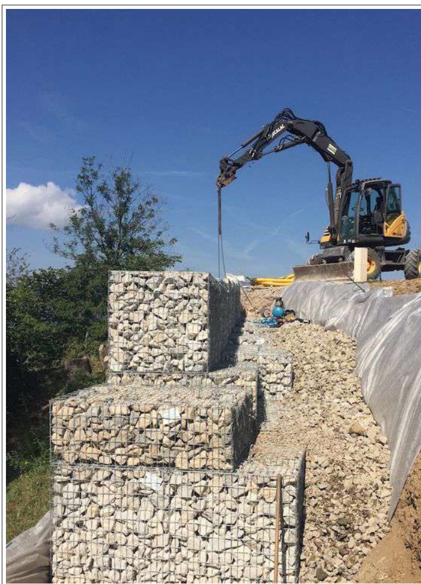
Figure 9.11. Exemple d'écran en gabion.
