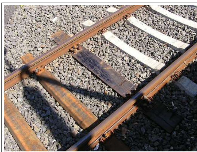
Figure 7.16. Traverse métalliques.
