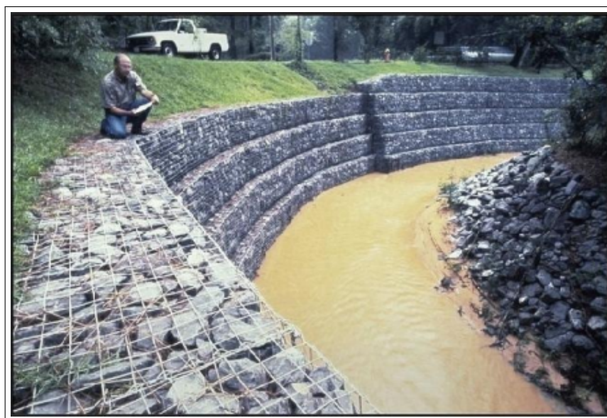
Figure 5.3: Les murs en gabions.
