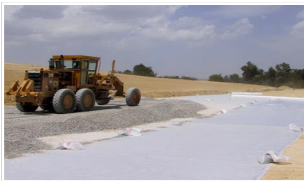
Figure 5.9: Renforcement par géogrilles .
