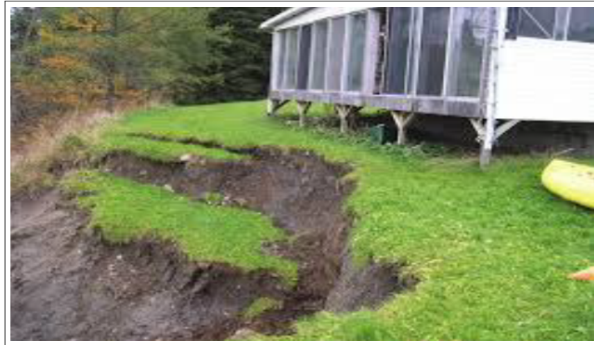
Figure 1.18: Glissement du aux surcharges au sommet du talus.
