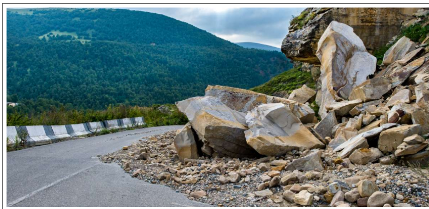
Figure 1.14: Eboulement ou chute de pierre.
