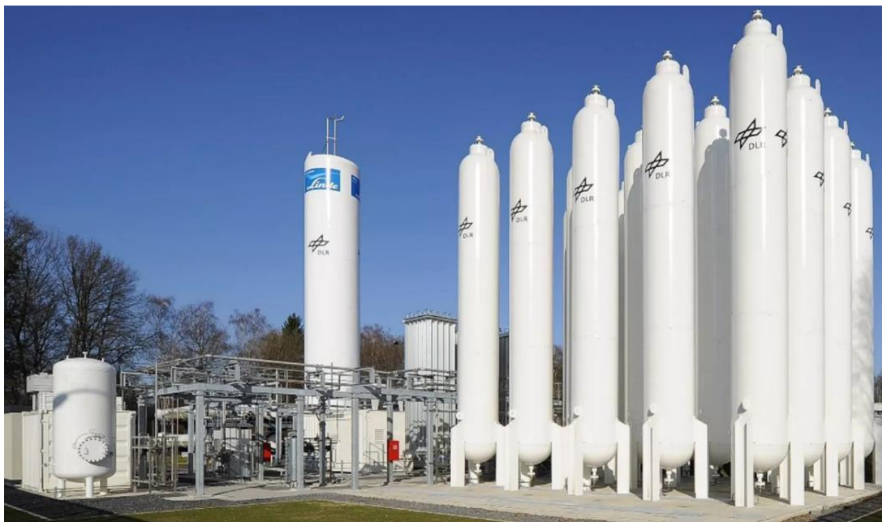
Figure I.15: Stockage d'hydrogène sous sa forme liquéfiée à -253^{\circ}\text{C} et 300 bars dans des réservoirs cryogéniques.
