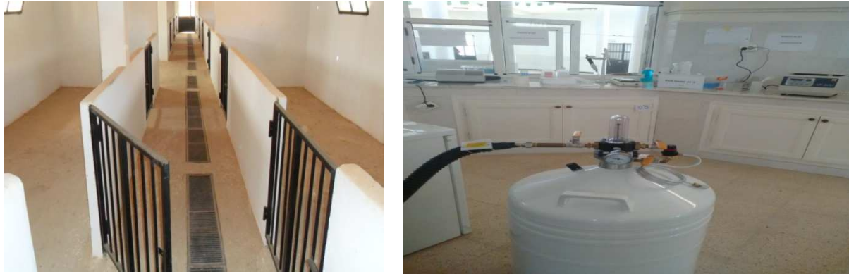
Figure 6 : Ecuries et bloc dédié au laboratoire (photo personnelle CNIAAG, 2024)
