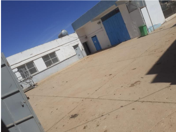
Figure 30 la bergerie sanitaire l'habitat
