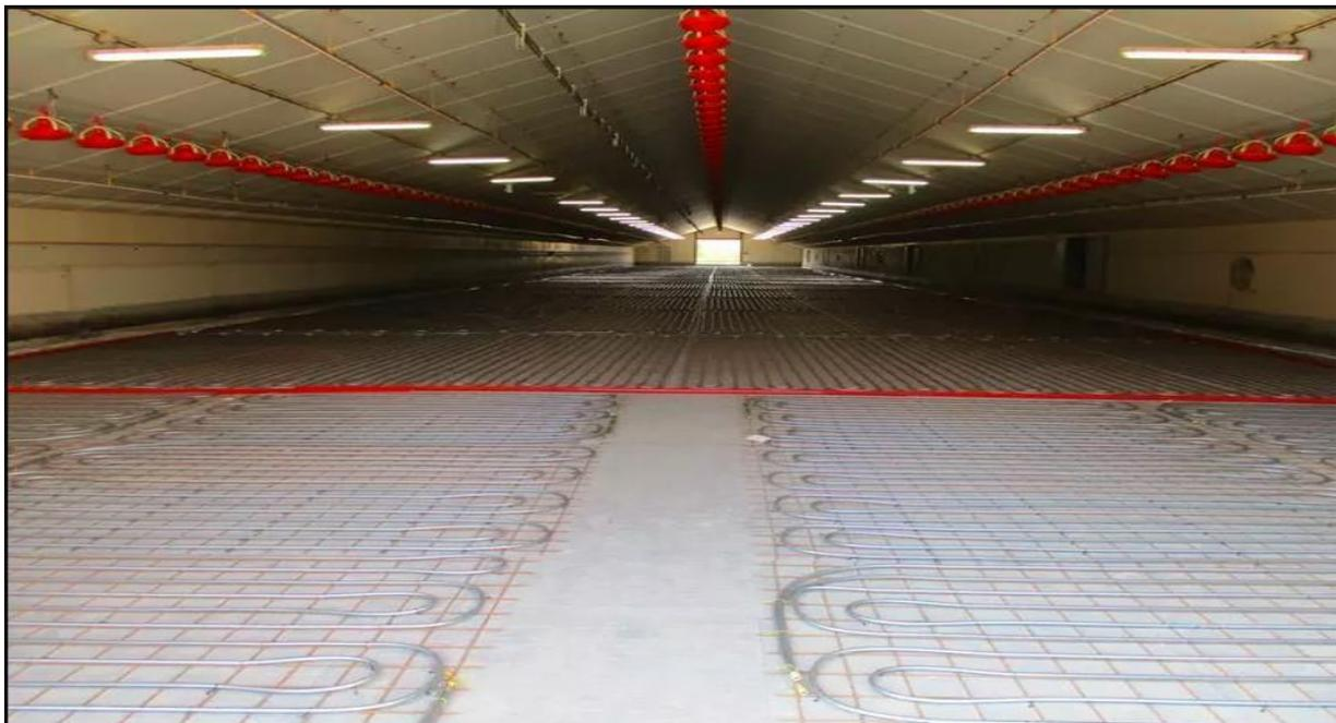
**Figure 6 :** Chauffage par le sol
