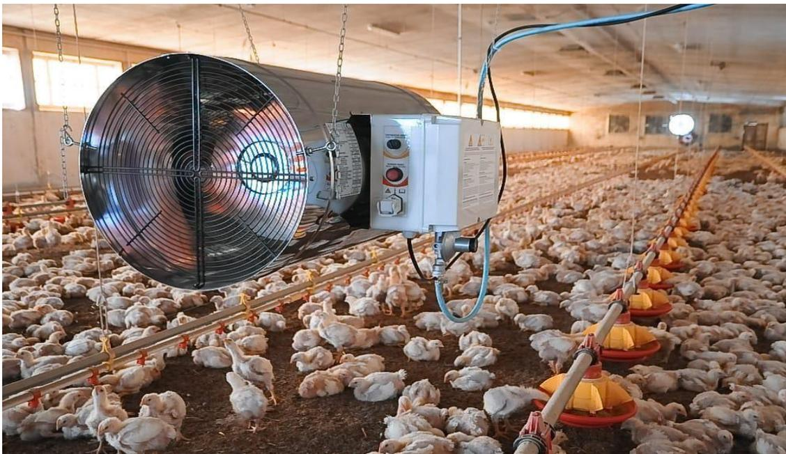
**Figure 4 :** Chauffage à air pulsé
