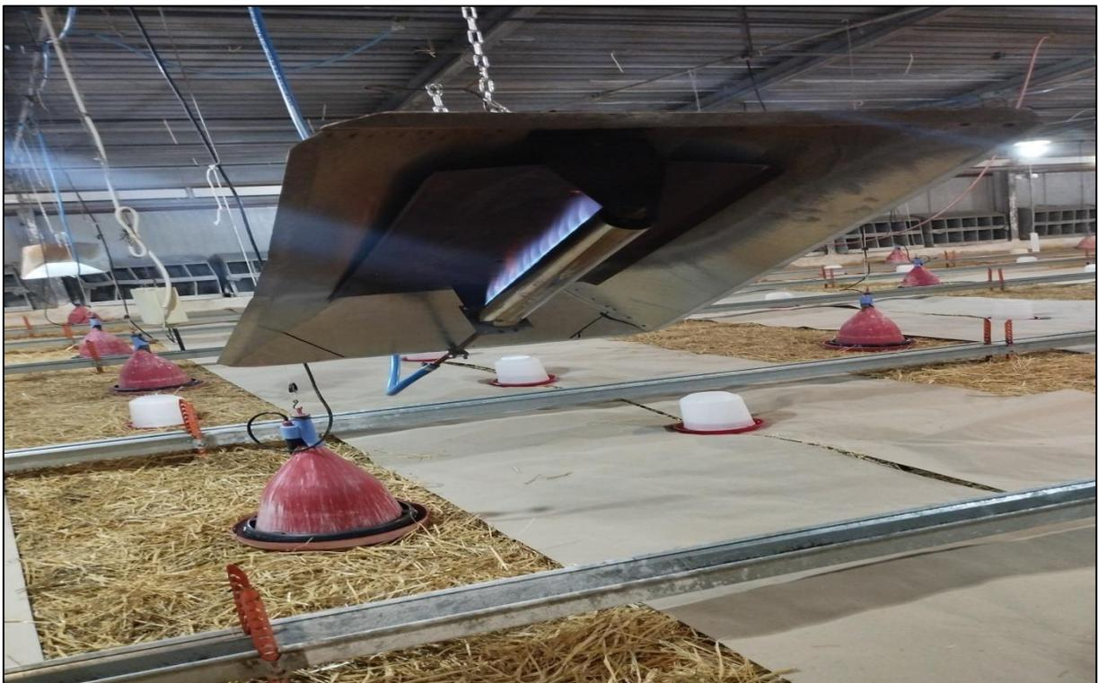
**Figure 18 :** les radiants utilisés dans le bâtiment
