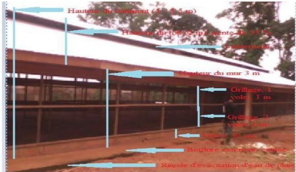
Figure 32 : Dimension des différentes parties d'un bâtiment à ventilation naturelle
