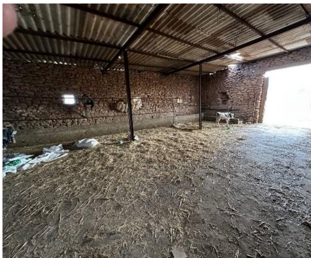
Figure 14 : bâtiment délavage (Photo personnelle )
