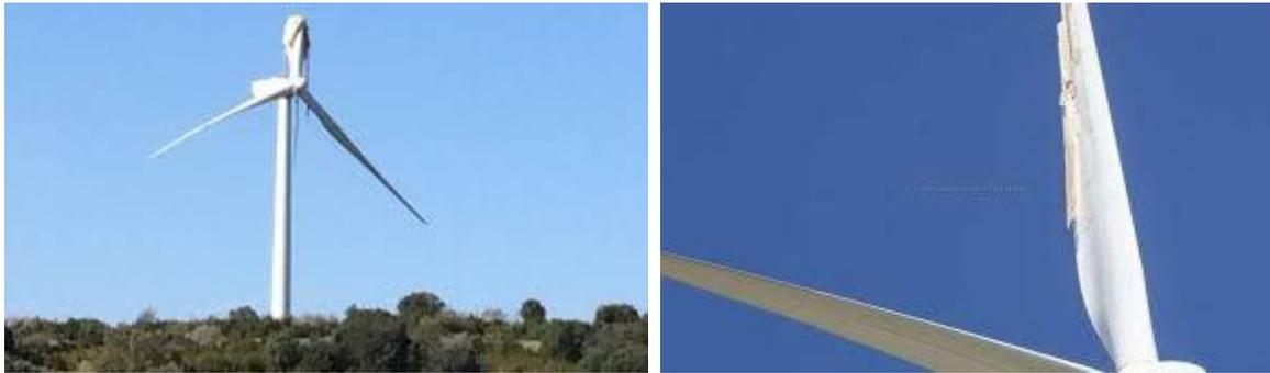
Figure II-9 Pales d'éoliennes détruite par la foudre.
