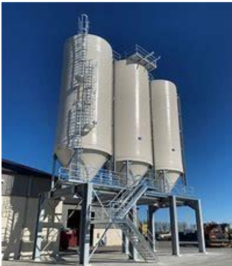
Figure (13) : Silos de stockage des grains
