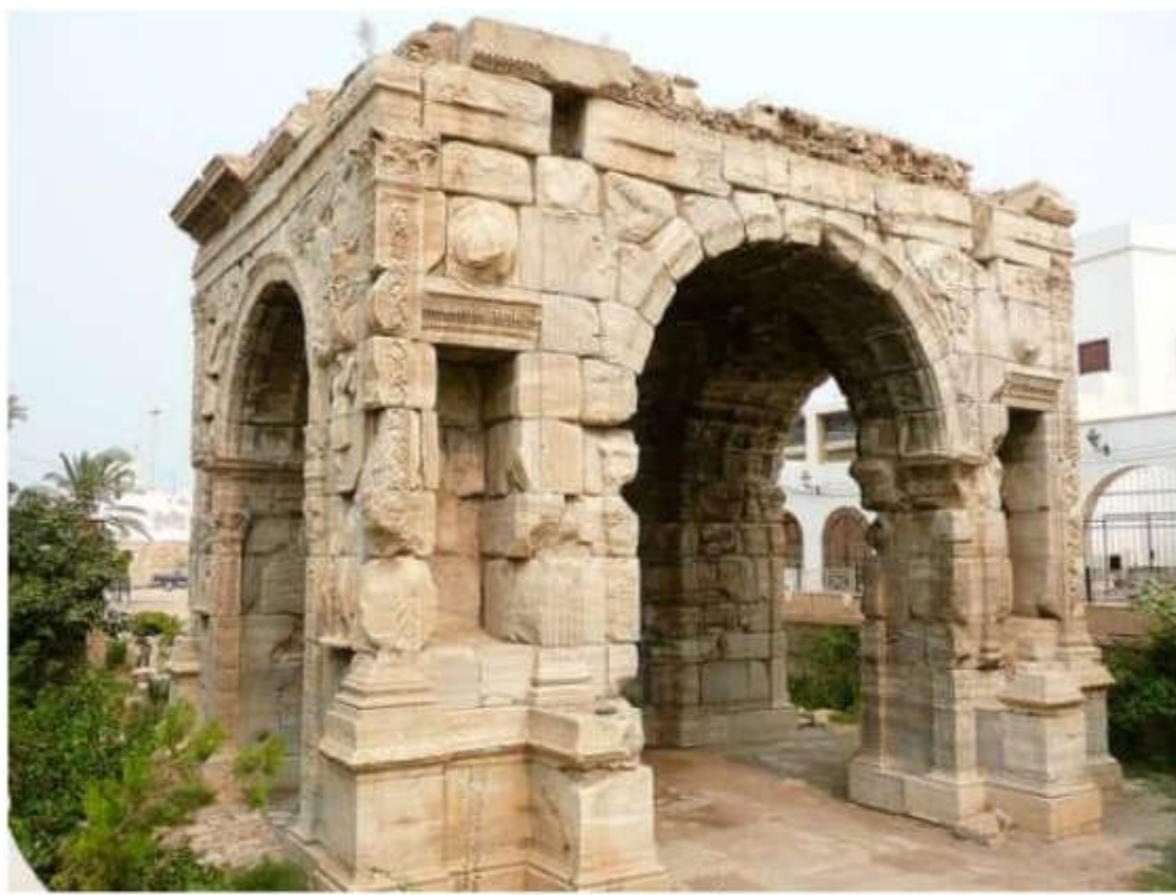
الشكل 14 قوس ماركوس أوريليوس في أويا ( طرابلس ليبيا), بعد اجراء الترميمات عليه حاليا
