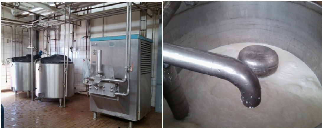
Photo N° 20: Refroidissement.GT. Photo N° 21 : Bac de lait.GT.
